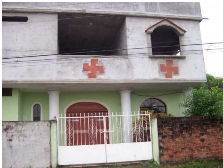
Casa con pared de ladrillo
