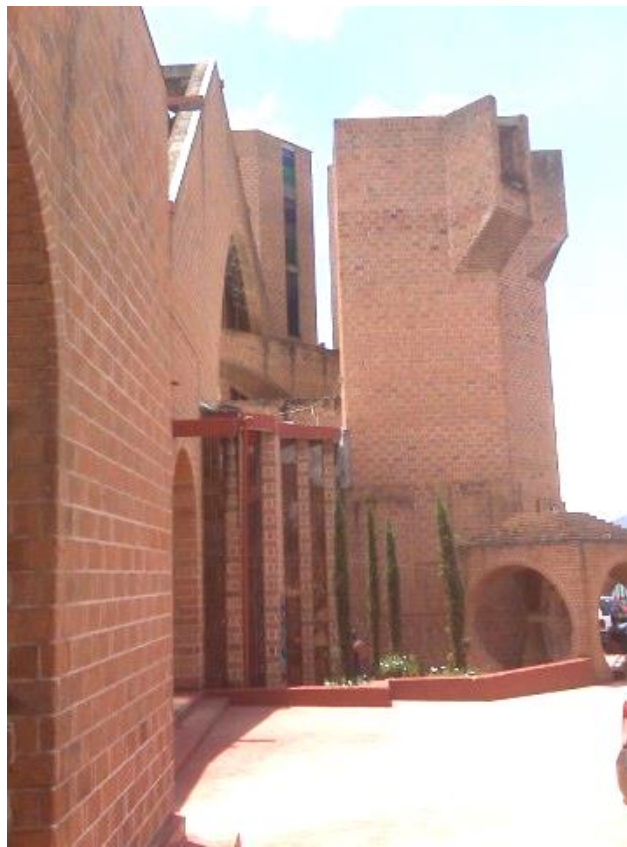
Vista exterior de la capilla
