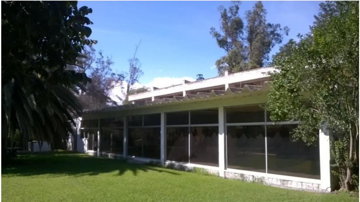
Fotografía 20: Hacienda, fachada posterior (piscina)
