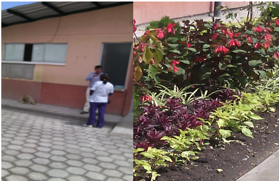
FIGURA No. 15 Infraestructura del Hospital Machachi Foto del año 2015
