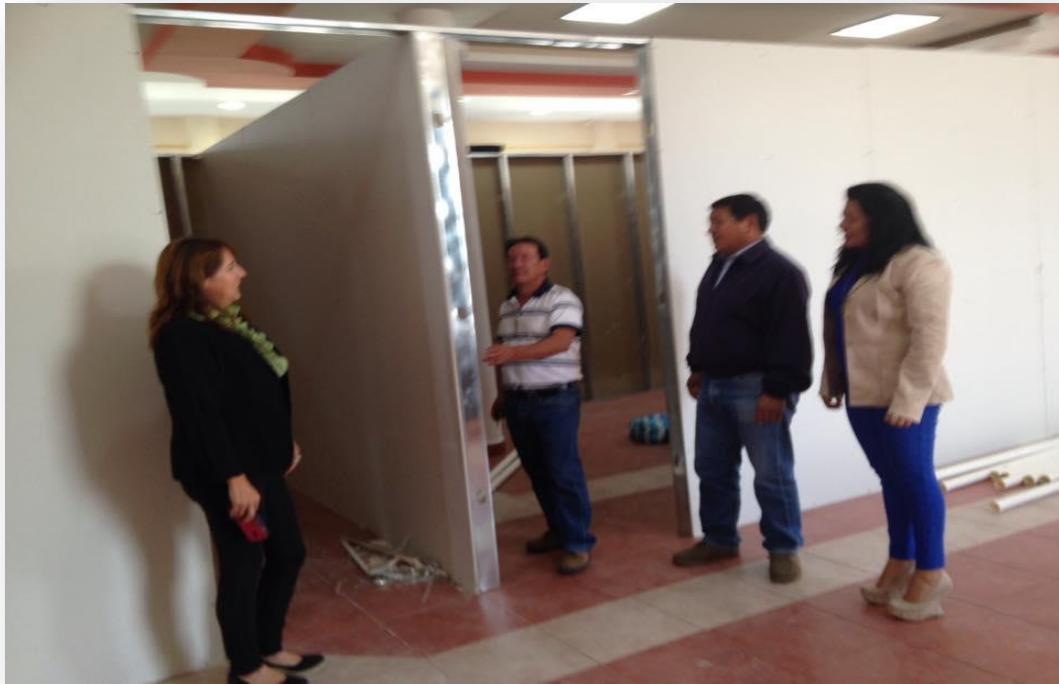
FIGURA No. 12 Infraestructura del Hospital Machachi Foto del año 2015
