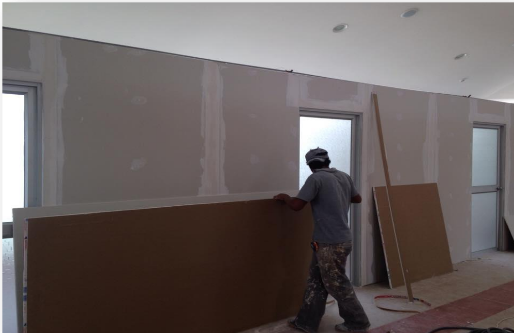
FIGURA No. 13 Infraestructura del Hospital Machachi Foto del año 2015
