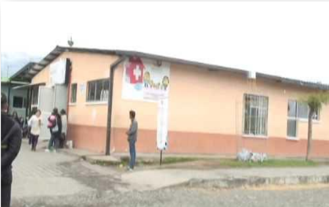
FIGURA No. 2 Área de Salud N° 16 del Hospital Machachi Foto del año 2015
