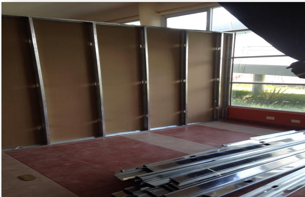
FIGURA No. 11 Infraestructura del Hospital Machachi Foto del año 2015
