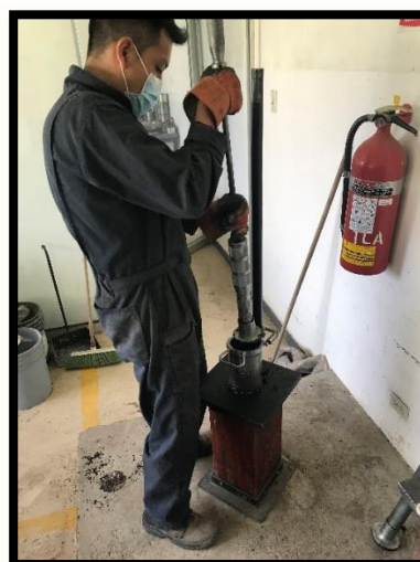
Fotografía 0.5 Compactación de la Mezcla
