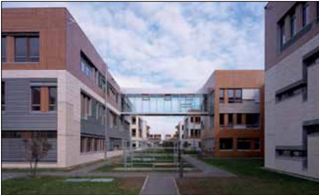
Queda demostrado que en las instalaciones de iluminación de un edificio, puede abrirse un claro ahorro potencial de energía con KNX. Foto: Infineon/Heinemann
