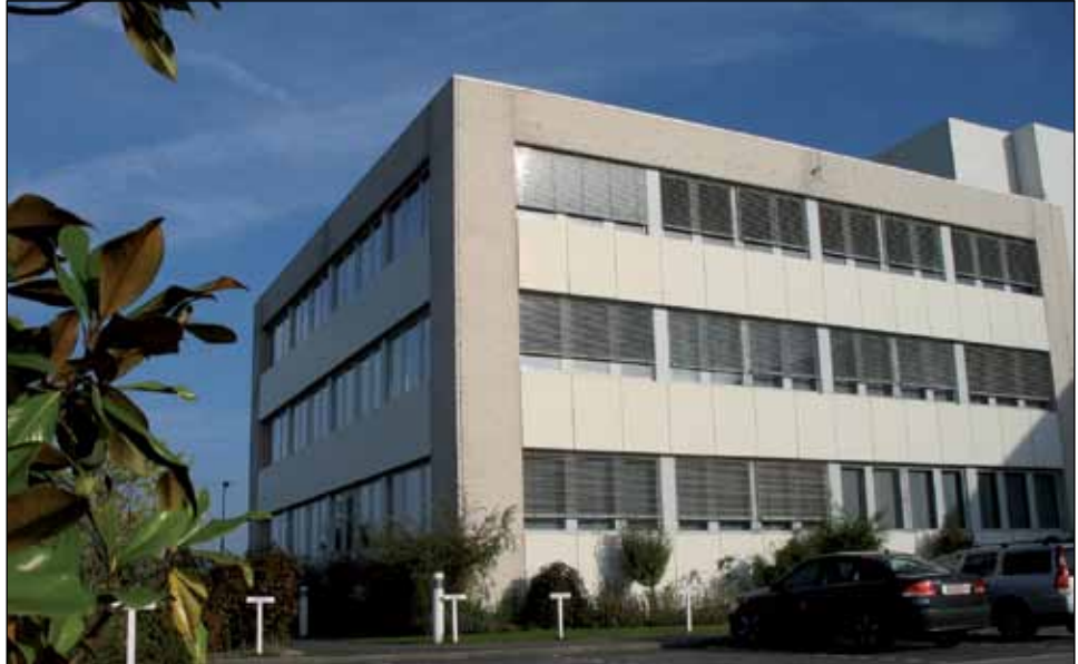
Un sistema de protección de sol controlado por sensor reduce la carga de refrigeración
