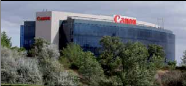
La fachada curvada de la nueva sede de Canon es energéticamente beneficiosa
