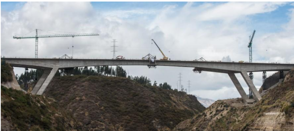
Construcción Puente sobre el Río Chiche
