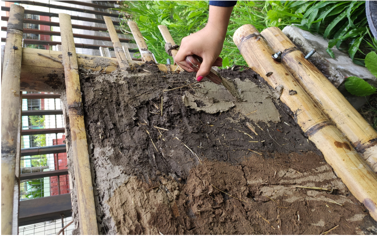
Figura 159: Aplicación de revestimiento en prototipo de Bahareque. Elaboración: (Armendáriz & Cisneros,2019).
