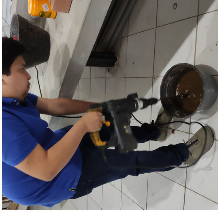
Figura 144: Mezcla con taladro y broca especial. Elaboración: (Armendáriz & Cisneros,2019).
