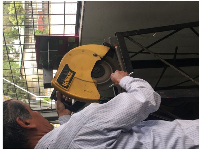
Figura 92: Corte de varilla roscada. Elaboración: (Armendáriz & Cisneros,2019).
