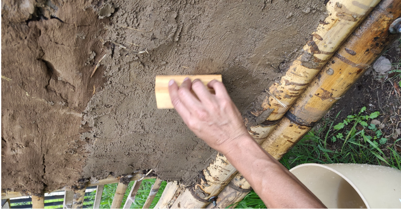
Figura 160: Aplicación de flotador en revestimiento. Elaboración: (Armendáriz & Cisneros,2019).
