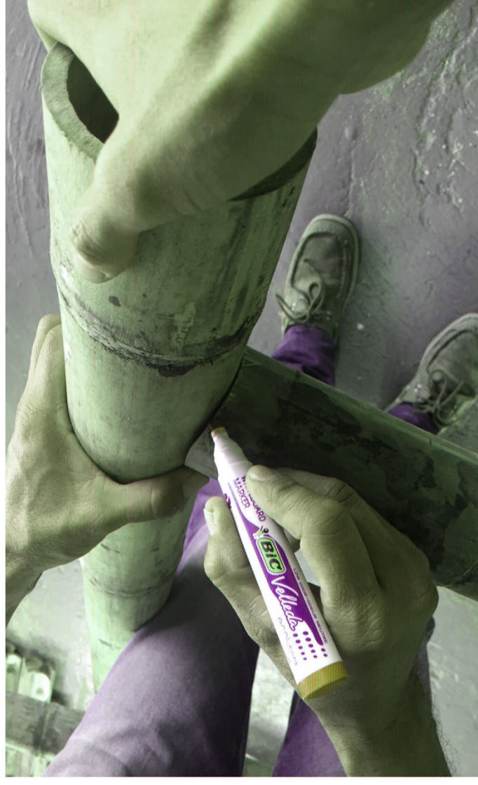
Figura 100: Trazado de anclajes. Elaboración: (Armendáriz & Cisneros,2019).
