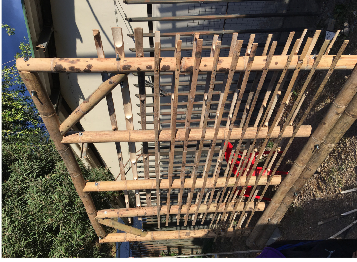
Figura 109: Estructura completa de muro de Bahareque. Elaboración: (Armendáriz & Cisneros,2019).
