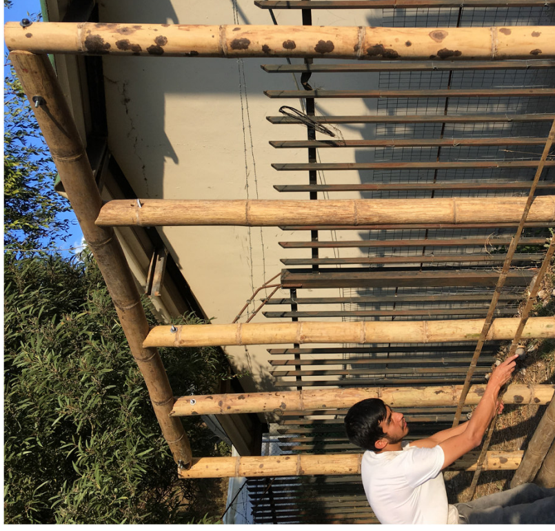
Figura 107: Colocación de tiras de caña guadua. Elaboración: (Armendáriz & Cisneros,2019).
