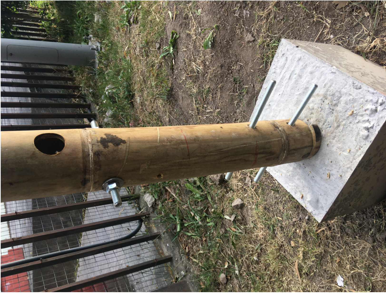
Figura 105: Anclaje final de columna de caña guadua con la sobre cimentación. Elaboración: (Armendáriz & Cisneros,2019).
