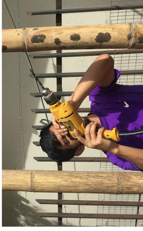
Figura 108: Perforaciones en sitio para colocar las diagonales. Elaboración: (Armendáriz & Cisneros,2019).
