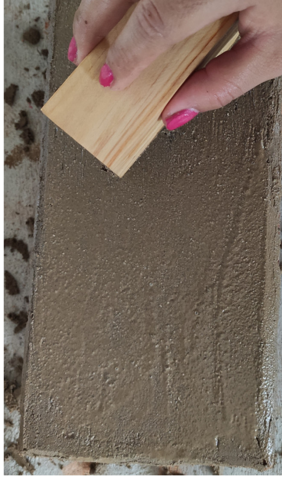
Figura 158: Flotador para nivelar el acabado. Elaboración: (Armendáriz & Cisneros,2019).
