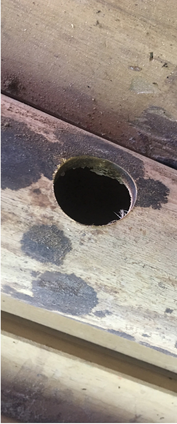
Figura 104: Perforación en caña guadua. Elaboración: (Armendáriz & Cisneros,2019).
