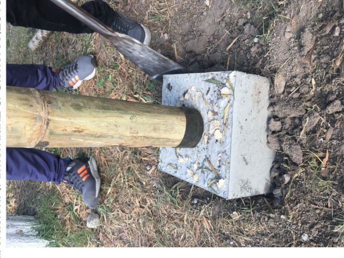
Figura 96: Dado impermeabilización. Elaboración: (Armendáriz & Cisneros,2019).
