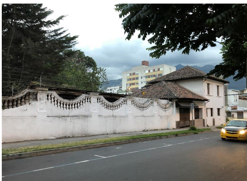
Figura 39. Exterior del Palacio de Barba. Elaboración propia 2018.
