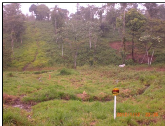
Fotografía N° 8. Oleoducto enterrado en El Triunfo ( Calidad Ambiental, 2012. )
