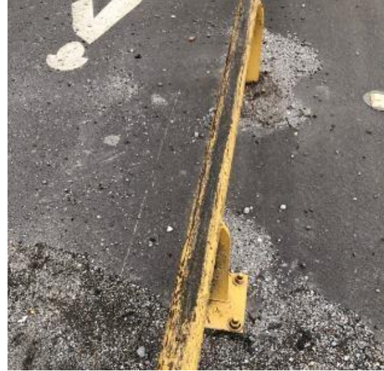
Barandas de Ciclovía
