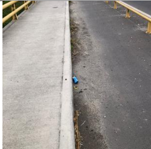
Acumulación de basura en el sistema de drenaje de los extremos
