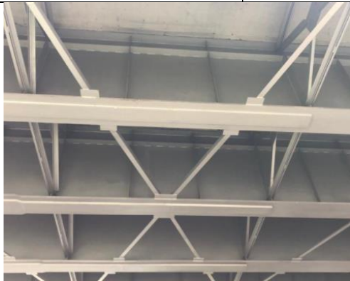
Vigas de Acero A588
