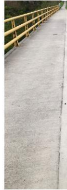
Acera de hormigón
