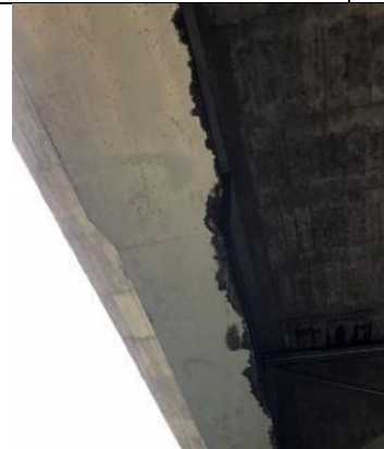
Vigas de Acero A588
