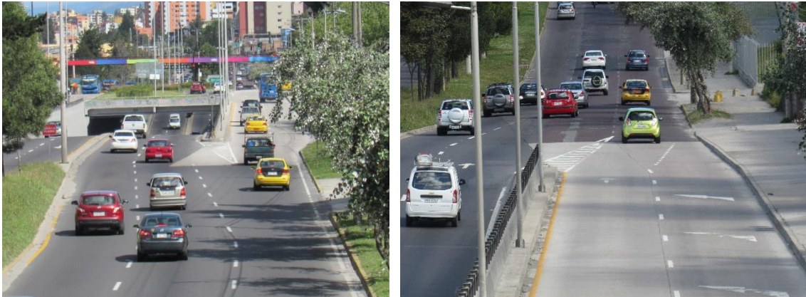
Foto N° 3-9: Transición entre los ramales y el paso deprimido
