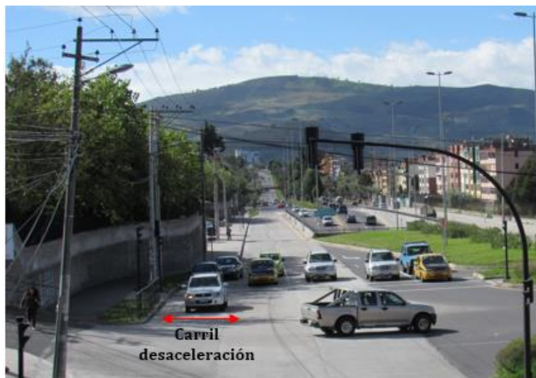
Foto N° 3-12: Carril de desaceleración para giros a la derecha
