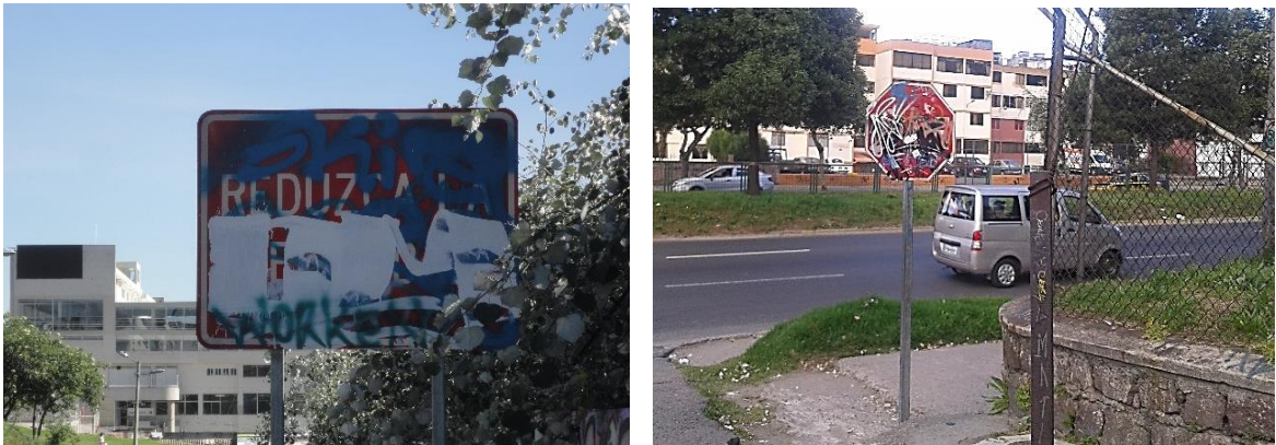
Foto N° 3-17: Señales de tránsito en mal estado
