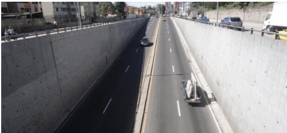
Foto N° 3-5: Entrada al paso deprimido del intercambiador Fernández Salvador
