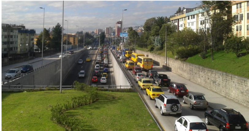
Foto N° 5-3: Congestión vehicular después de la construcción del Intercambiador
