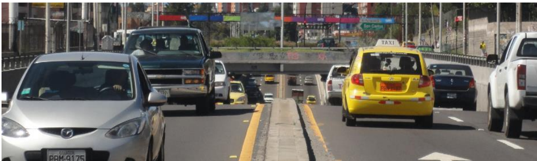
Foto N° 1-1: Paso de desnivel del Intercambiador Fernández Salvador
