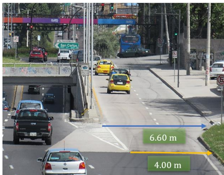
Foto N° 3-8: Entrada y salida del ramal
