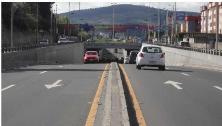
Foto N° 3-4: Paso deprimido del intercambiador Fernández Salvador
