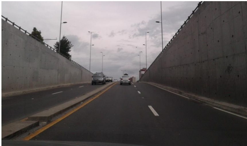
Foto N° 3-6: Rampa de salida del paso deprimido
