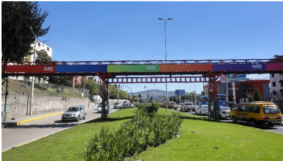
Foto N° 3-16: Puente peatonal sobre la intersección a nivel
