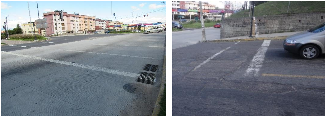
Foto N° 3-32: Línea de Pare
