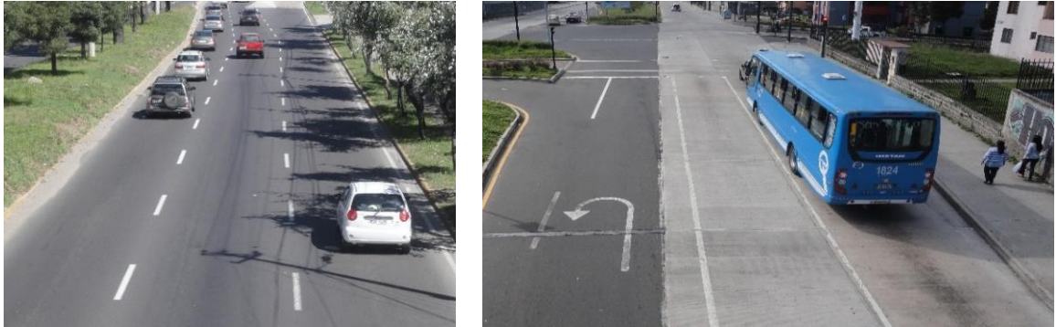
Foto N° 3-27: Líneas de separación de carriles
