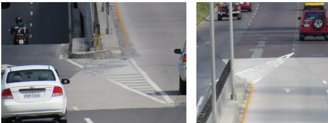
Foto N° 3-38: Chevrones (área de divergencia y convergencia)
