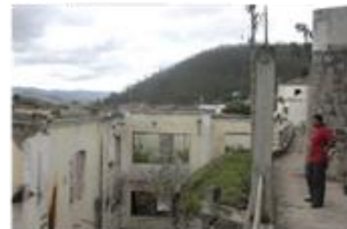
03-10-04-01-000-000001A_4 Vista superior hacia la derecha del conjunto en Píscar, se puede apreciar
