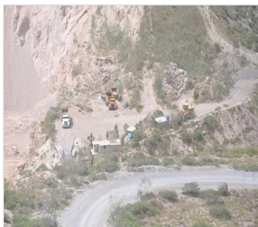
Fotografía N°2.6: Cantera “El Guabo”
