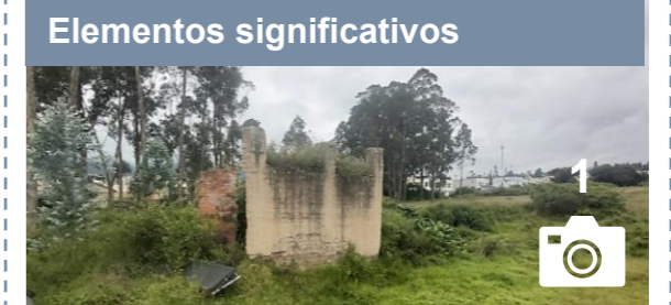
Figura 79, Antiguo horno de ladrillo. Fuente: Elaboración propia.
