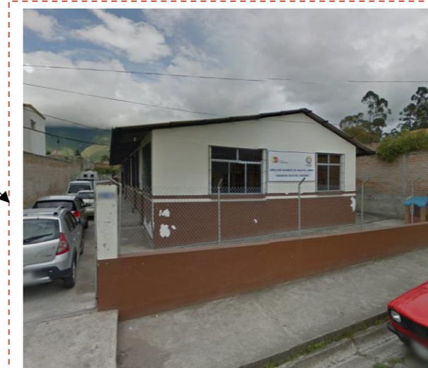
Figura 48, Subcentro de salud. Fuente: Elaboración propia.
