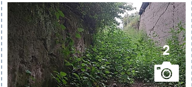
Figura 77, Callejón al lado oeste del predio Fuente: Elaboración propia.
