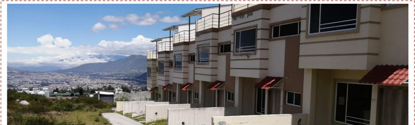
Figura 49, Conjunto habitacional inconcluso. Fuente: Elaboración propia.
