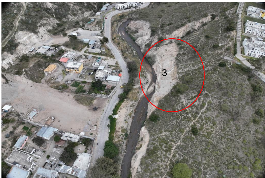
Fotografía 3: Remoción de masas y socavamiento en el punto crítico 3
