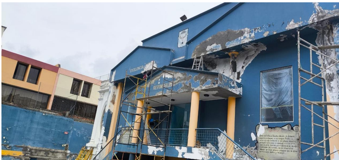
Gráfico 23. Mantenimiento fachada posterior en proceso
