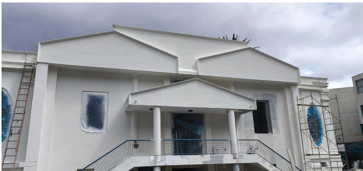
Gráfico 24. Mantenimiento fachada posterior en proceso
