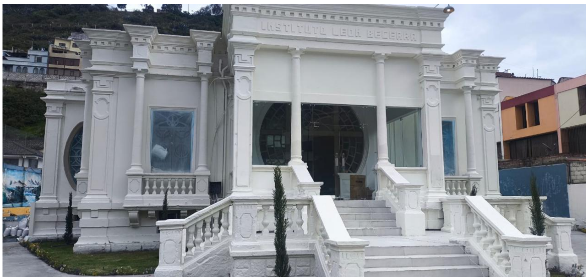
Gráfico 25. Mantenimiento fachada frontal en proceso
