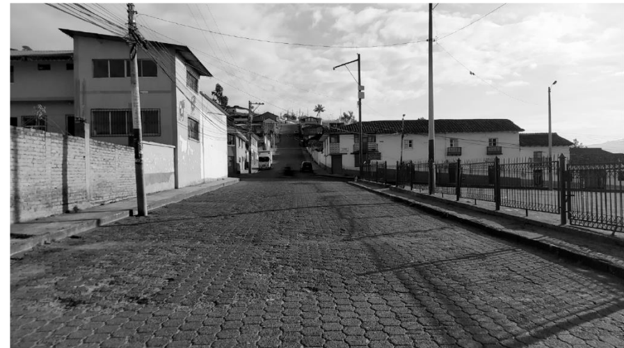
Calle Manuel Carrera- estado actual
