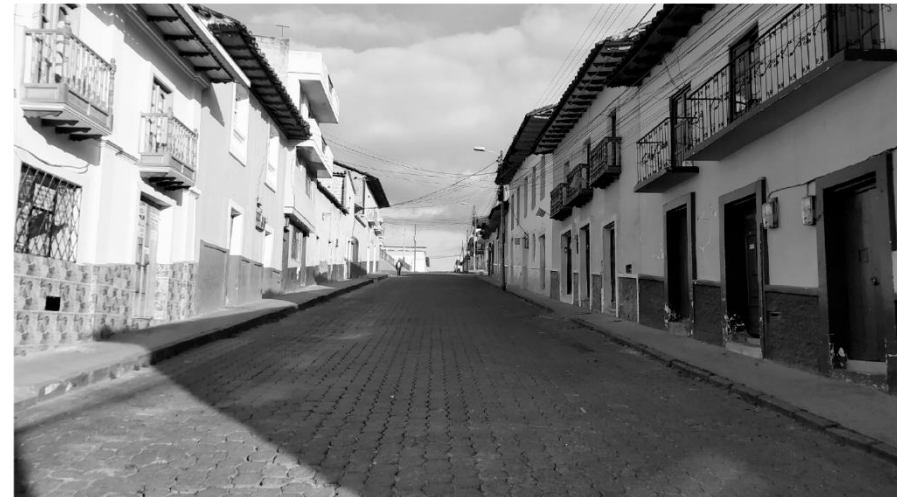
Calle Bolívar tramo 3- estado actual
