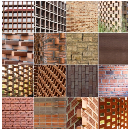
Figura 22. Aparejos y celosías en ladrillo, (Dejtiar, 2016)
