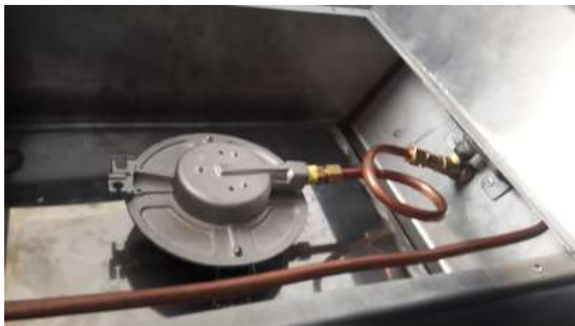
Imagen 44: Distribución de la línea de gas. Elaboración: Andrés Mejía.
