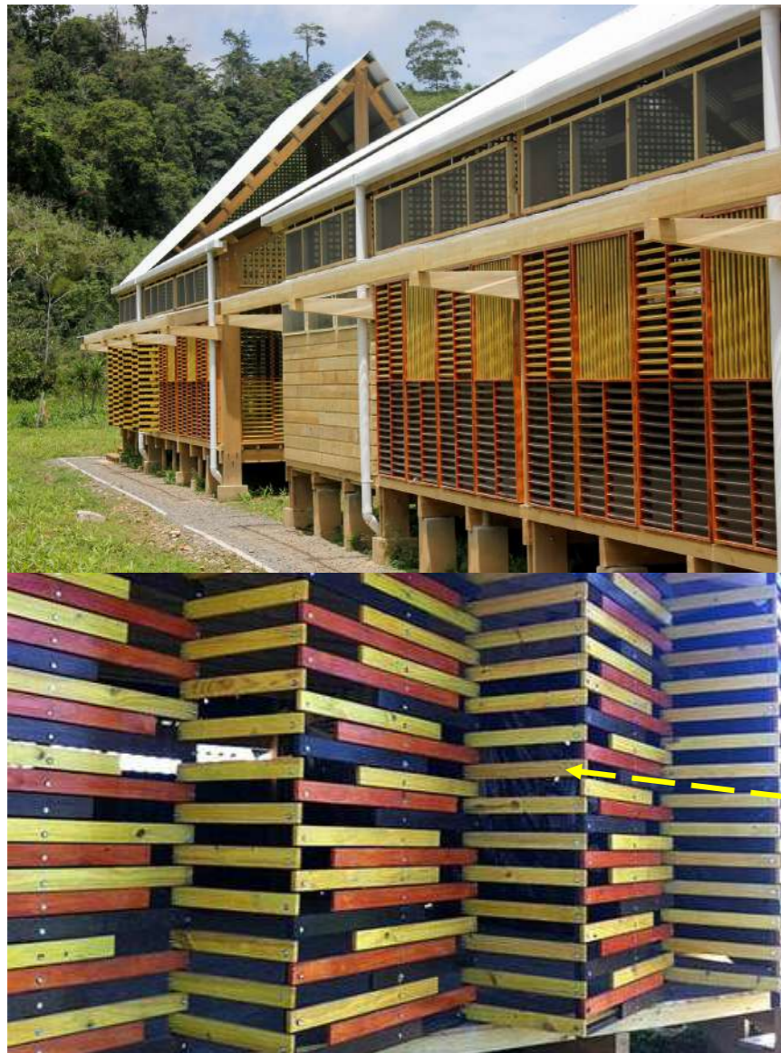
Imagen 61: Utilización y colocación de maderas en el proyecto Fuente: Plataforma de arquitectura
