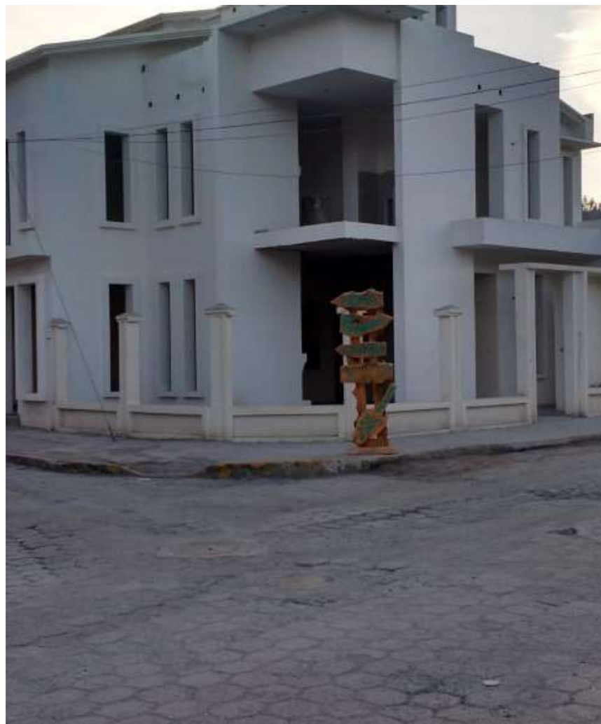
Imagen 135: Edificación semidura de la parroquia Fuente: Elaboración propia
