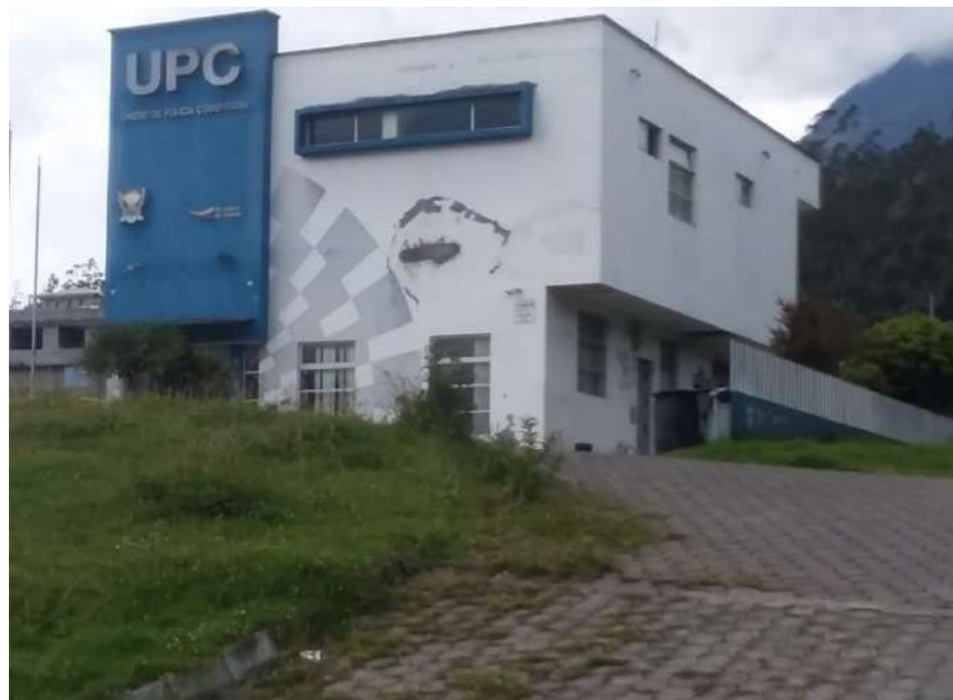
Imagen 125: Equipamiento de seguridad UPC Fuente: Elaboración propia
