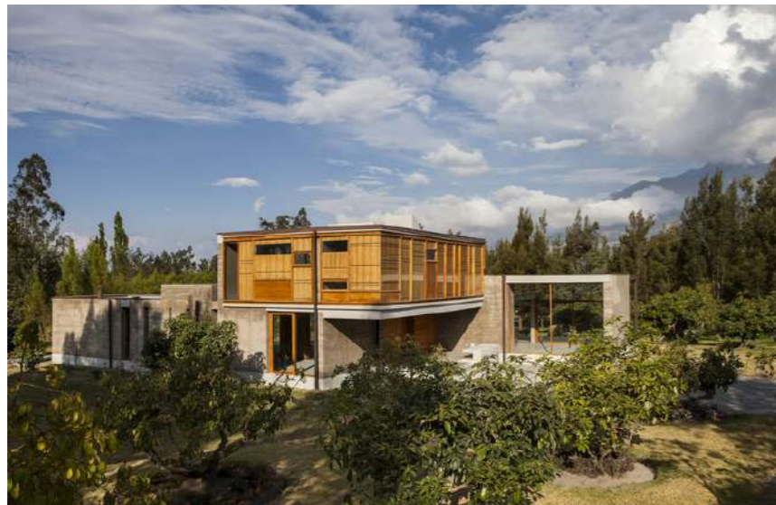
Imagen 76: Casa en Cotacachi Fuente: Plataforma de arquitectura
