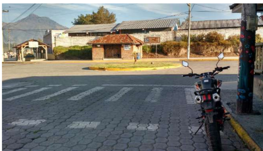
Imagen 141: Sector 5 Barrio Tahuantinsuyo Fuente: Elaboración propia
