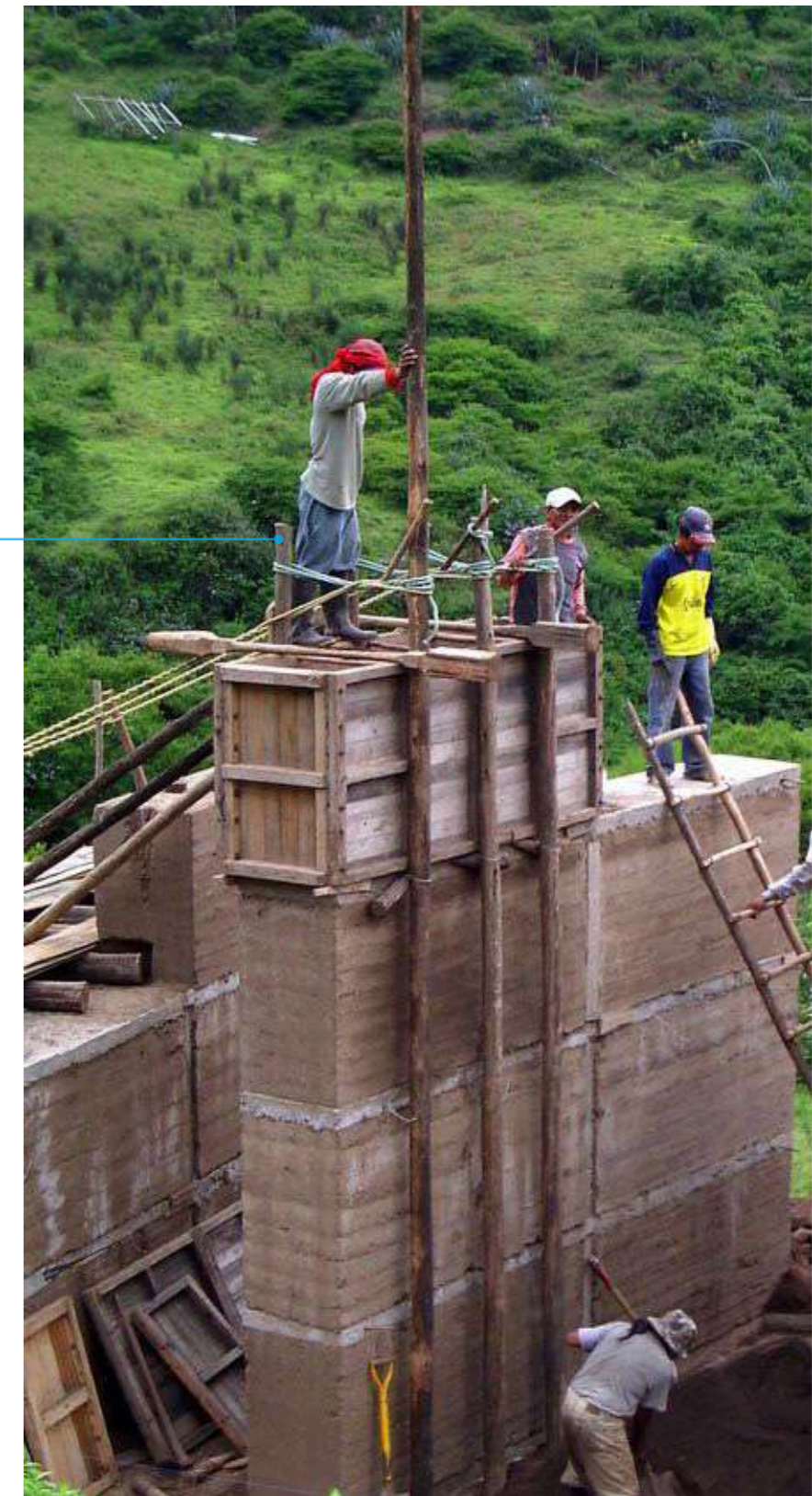
Imagen 104: Casa entre muros - proceso de construcción Fuente: Plataforma de arquitectura
