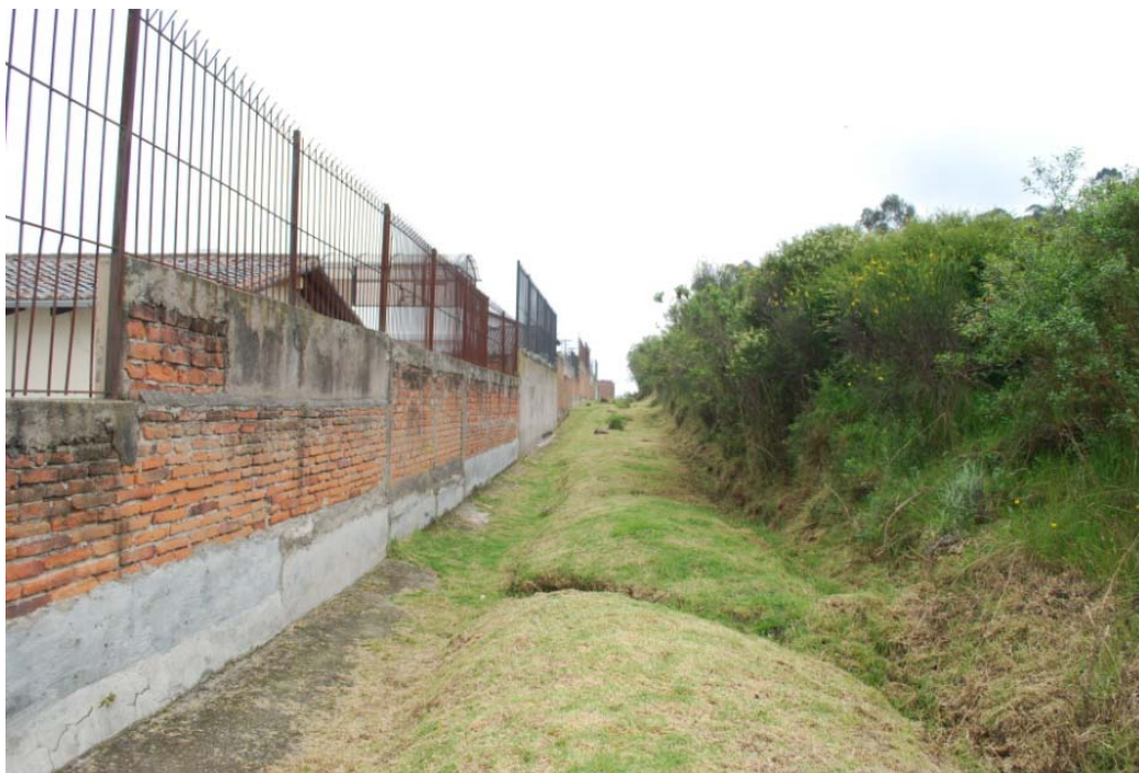
Ingreso Sur a la zona de emplazamiento
