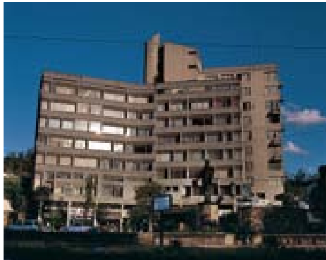
Edificio El Artigas
