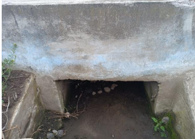
Figura 18. Material del cuerpo de alcantarilla de hormigón Fuente: (Elaboración Propia)
