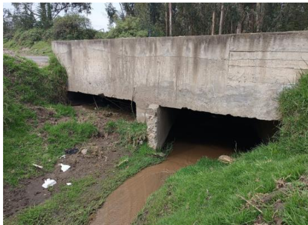
Figura 22. Alcantarilla tipo badén Fuente: (Elaboración Propia)
