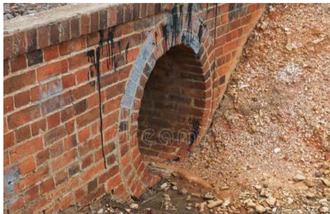
Figura 19. Material del cuerpo de alcantarilla de ladrillo Fuente: (Elaboración Propia)
