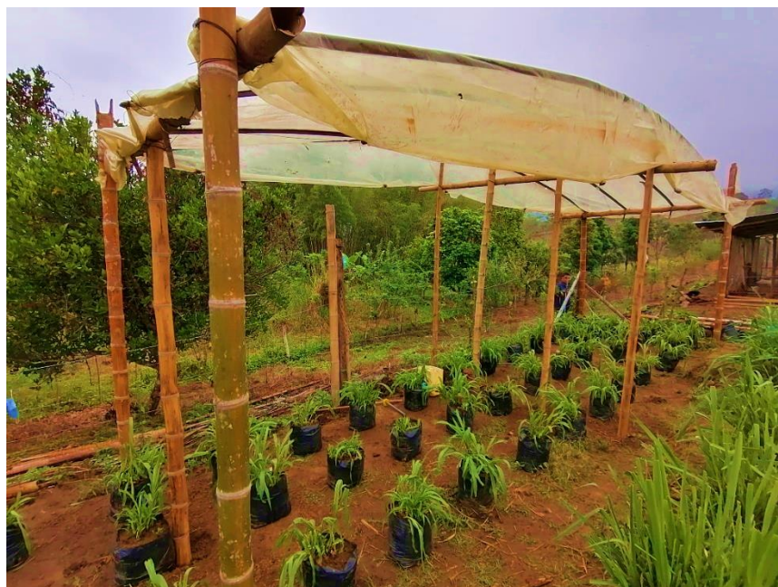
Figura 6: Montaje de tejado por exceso de precipitación del ensayo experimental.
