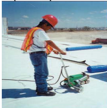
La impermeabilización en la construcción
