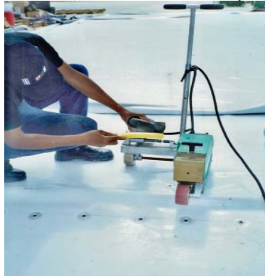
La impermeabilización en la construcción
