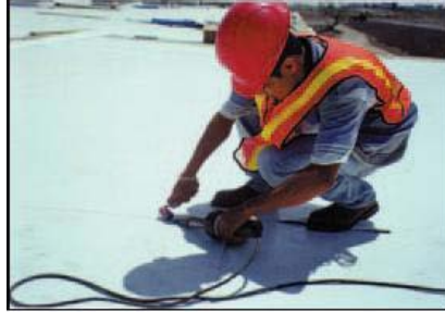
La impermeabilización en la construcción
