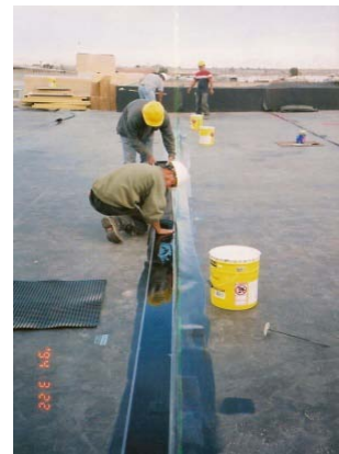
IMAGEN 4 Sellamiento entre lámina PVC y losa (sellamiento acuoso)
