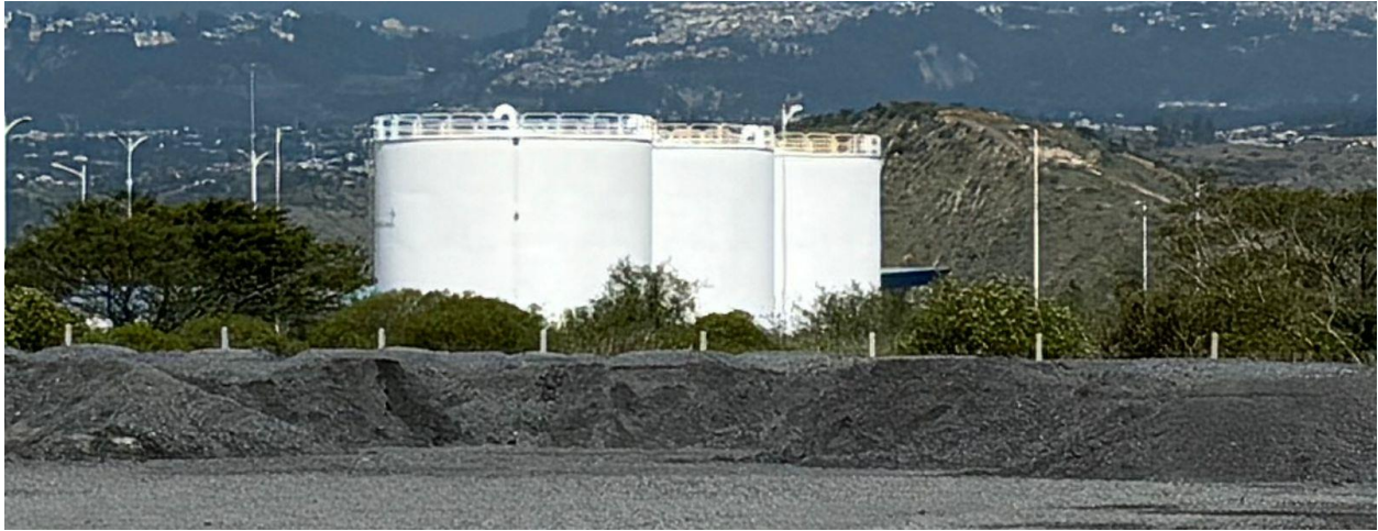
Ilustración 36. Almacenamiento de RAP en el Aeropuerto de Quito. Fuente: Raynier Nugra
