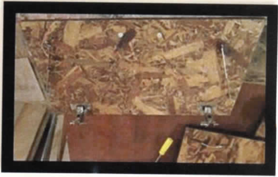
Imagen 53 Instalación de herrajes Fuente: Virginia Rampón Rosero, 02 de mayo de 2012.
