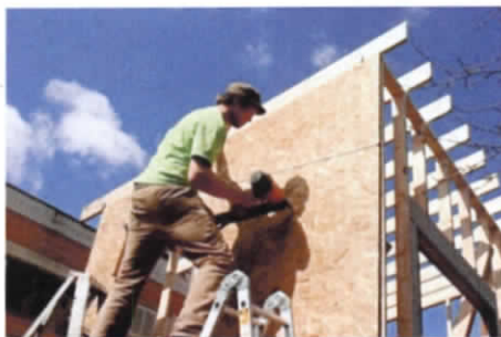
Imagen 13 Tableros de OSB en la construcción.
