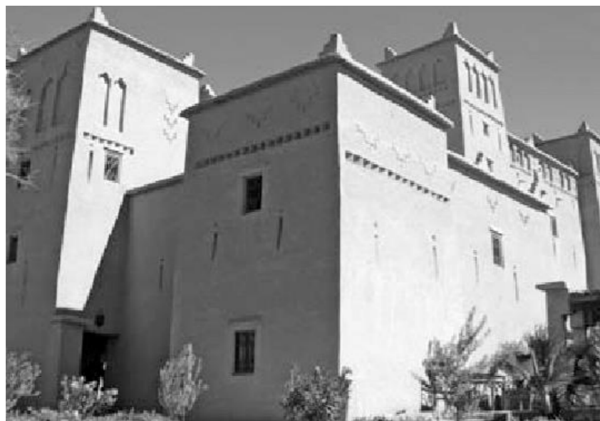
Figura 22 Rehabilitación de la Kasbah Ait Ben Moro.
