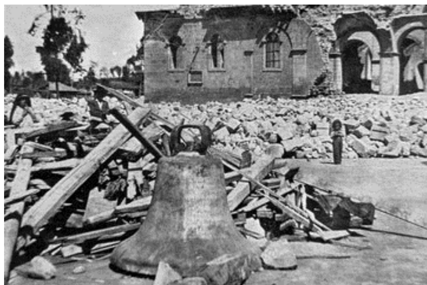
Figura 5 Escombros del terremoto de 1868.
