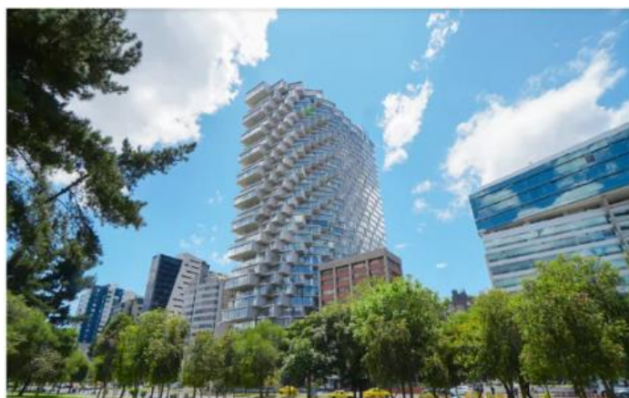
Figura 31. Edificio IQON Norte de Quito (Uribe Schwarzkopf, s. f.)
