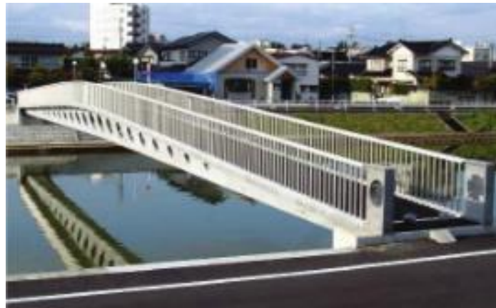
Figura 28. Puente peatonal Sakata-Mirai
