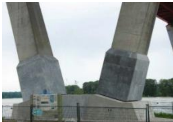
Figura 29. Refuerzo con HUAP en elementos estructurales del puente Mission.
