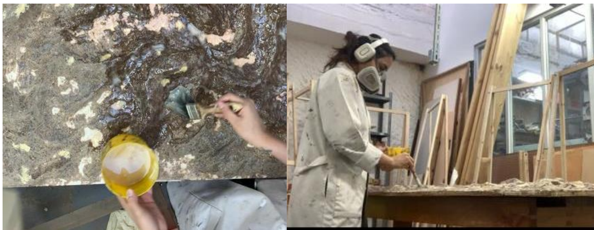
Figura 24 Aplicación de sellador.
