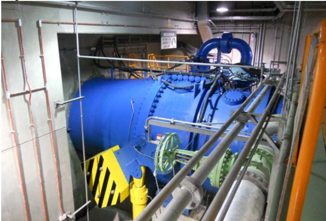
Descripción: Túnel de conducción Unidad N°1 Fotografía: David Burbano Montalvo
