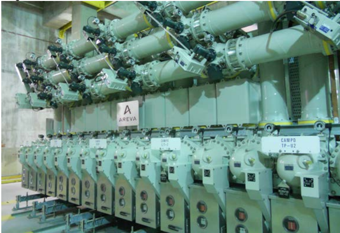
Descripción: Equipo eléctrico – Transformadores de potencia Fotografía: David Burbano Montalvo
