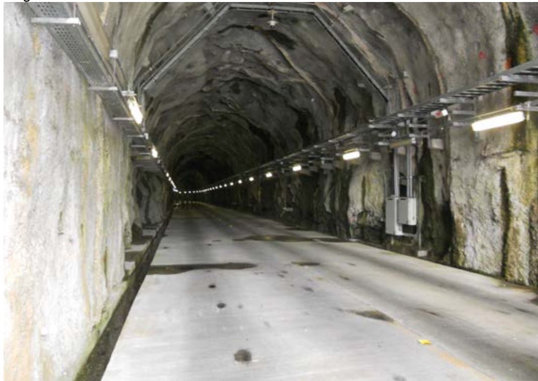
Descripción: Túnel de acceso a la Casa de Máquinas Fotografía: David Burbano Montalvo
