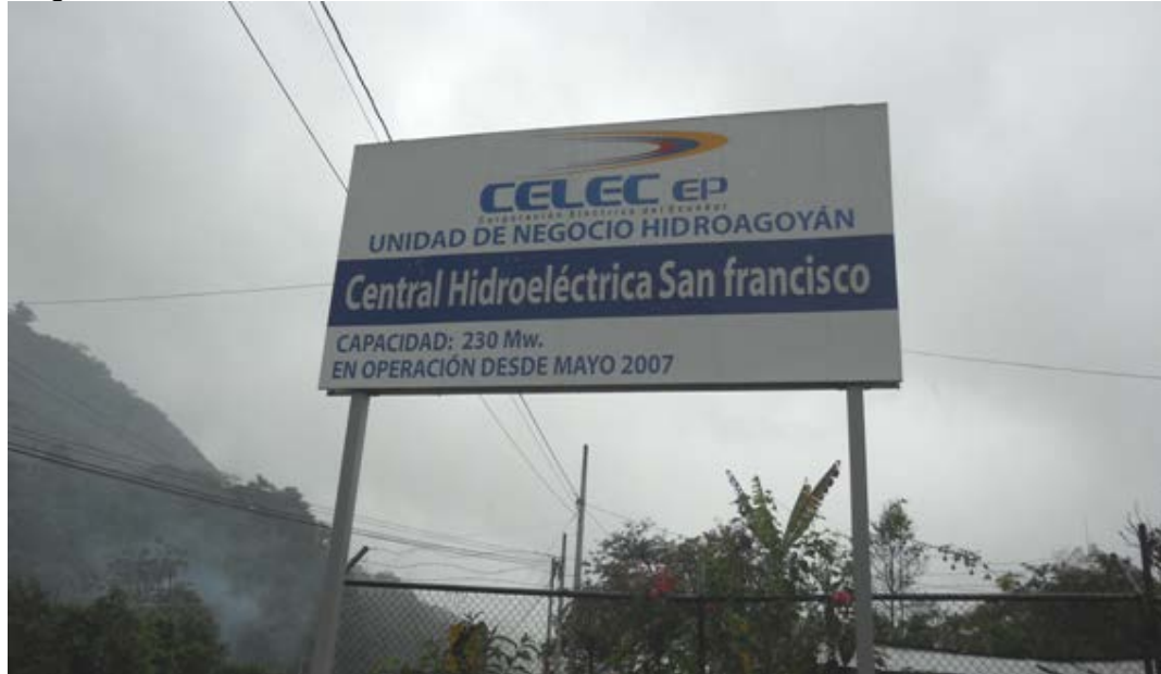
Descripción: Ingreso principal a la central, Km12 vía Baños – Puyo Fotografía: David Burbano Montalvo
