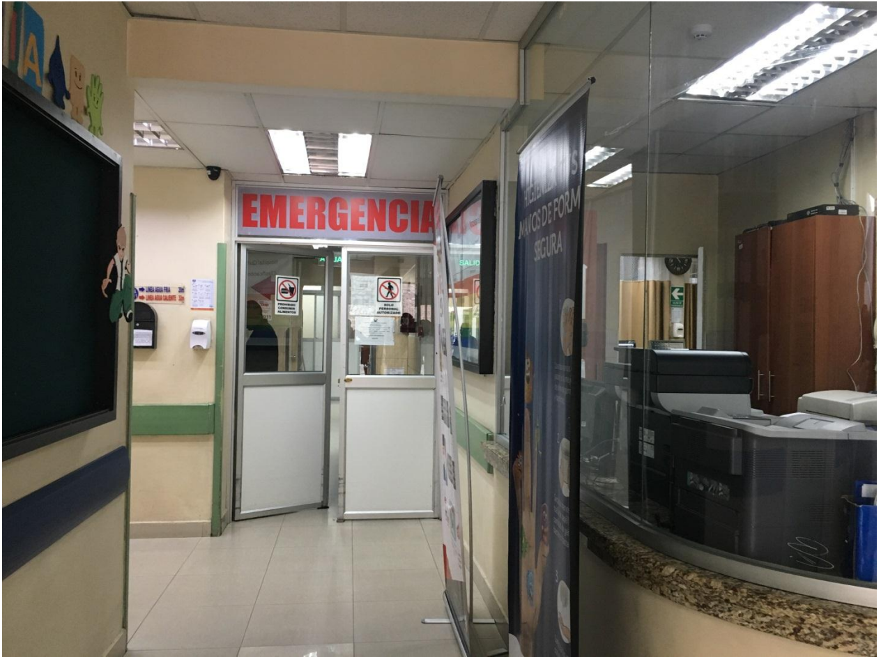
Fotografía 5: Ingreso a sala de emergencias
