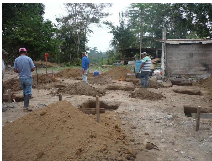
Figura No. 51. Aspectos técnicos de Excavación manual de suelo natural
