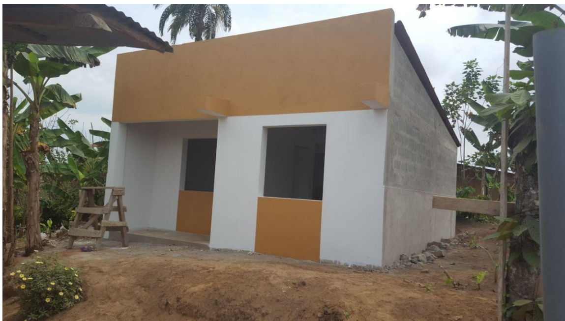
Figura No. 93. Fachada de vivienda emergente. San Pedro de Suma
