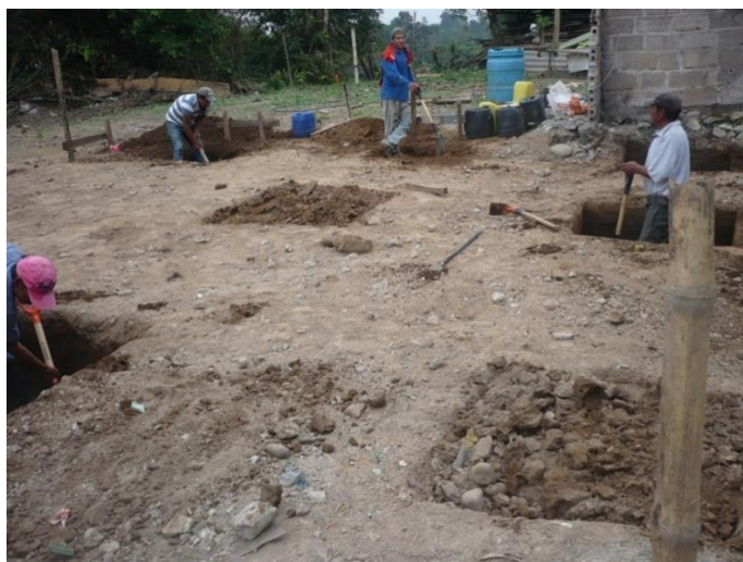
Figura No. 50. Aspectos técnicos de Mejoramiento de suelo
