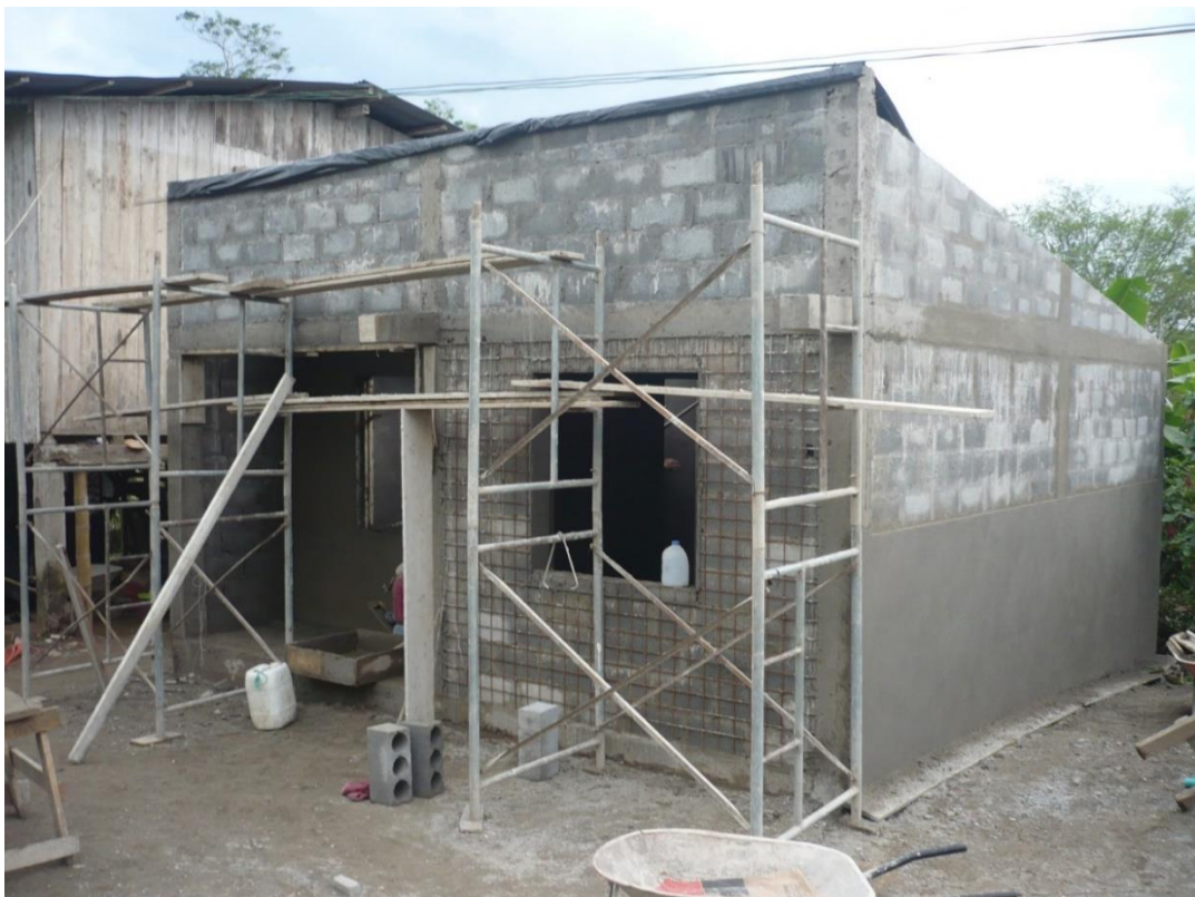
Figura No. 88. Método constructivo tradicional. Vivienda de carácter emergente, San Pedro de Suma
