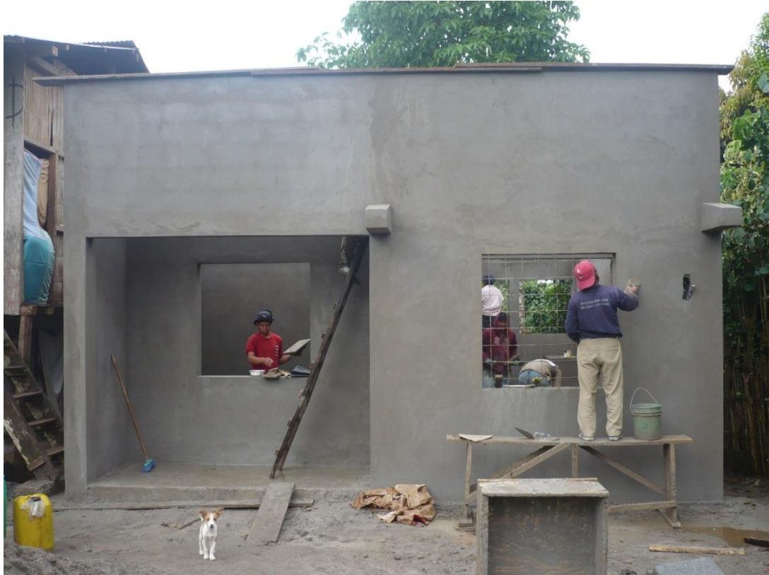
Figura No. 87. Método constructivo tradicional. Vivienda de carácter emergente, San Pedro de Suma
