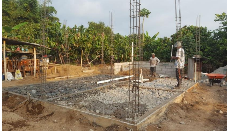
Figura No. 54. Aspectos técnicos de la Cimentación
