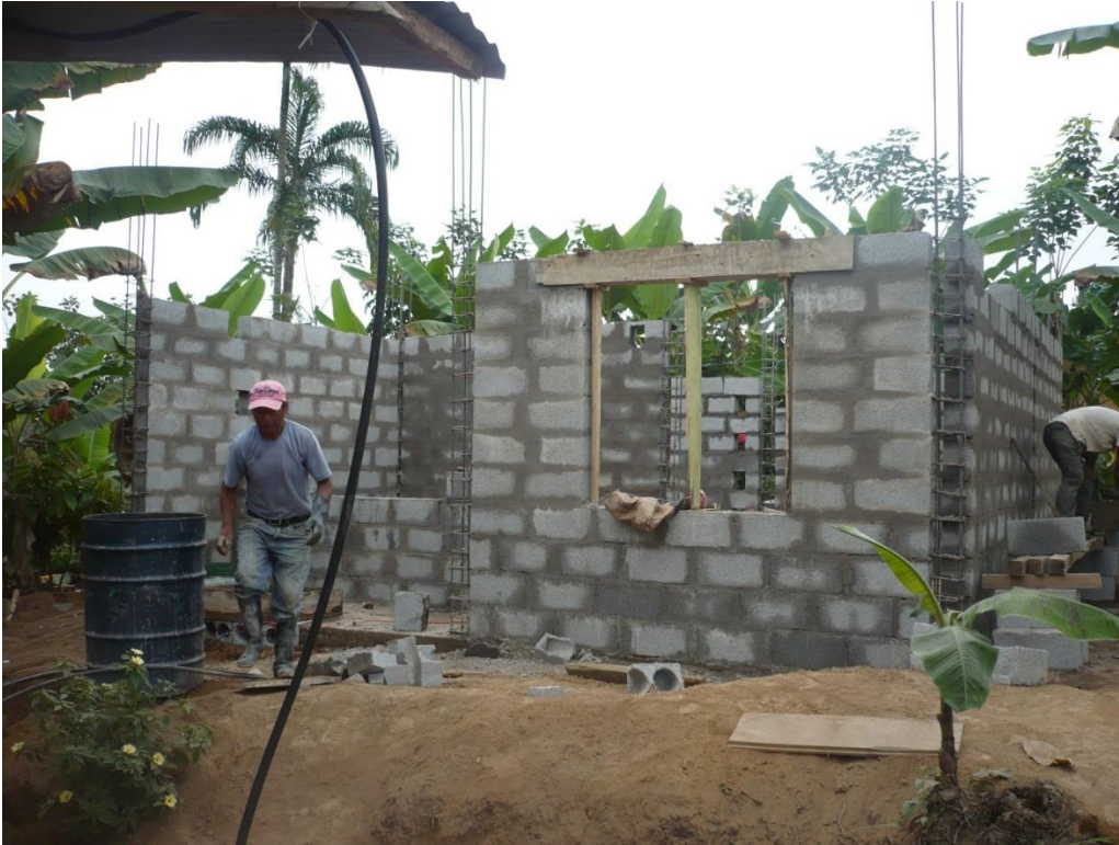
Figura No. 85. Método constructivo tradicional. Vivienda de carácter emergente, San Pedro de Suma
