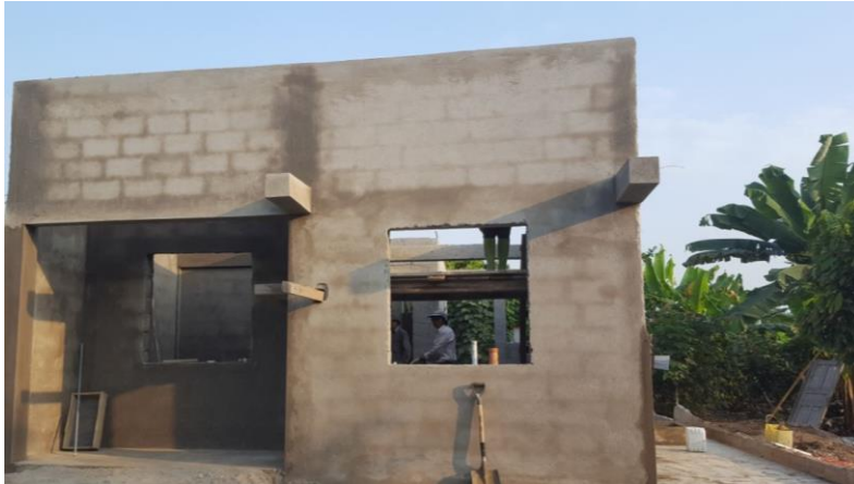
Figura No. 45. Aspectos técnicos de la estructura
