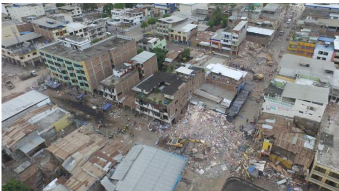
Figura No. 141. Edificaciones destruidas totalmente por el terremoto del 16 de Abril.
