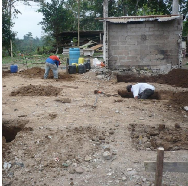
Figura No. 52. Aspectos técnicos de Relleno con suelo natural
