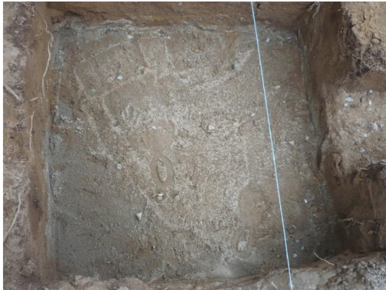
Figura No. 49. Aspectos técnicos de replanteo y nivelación manual
