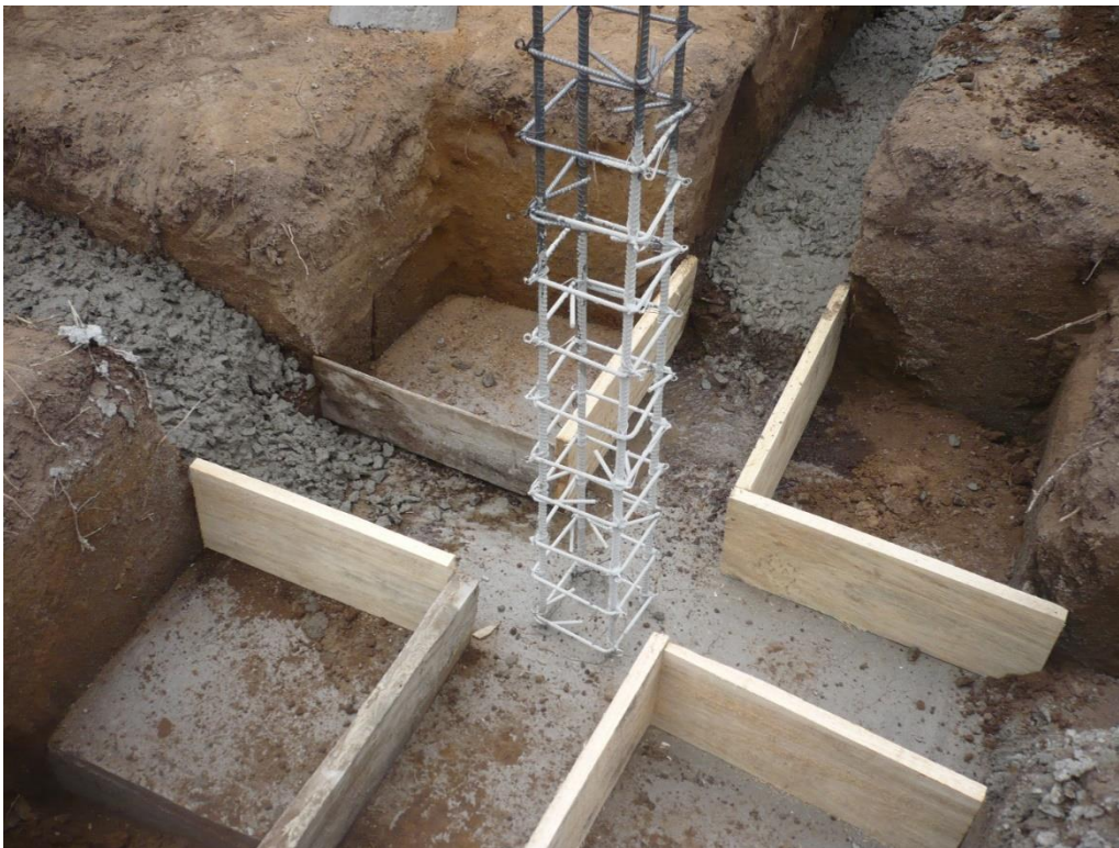
Figura No. 86. Método constructivo tradicional. Vivienda de carácter emergente, San Pedro de Suma
