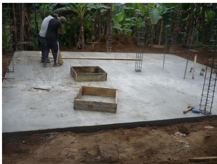
Figura No. 53. Aspectos técnicos de la Cimentación
