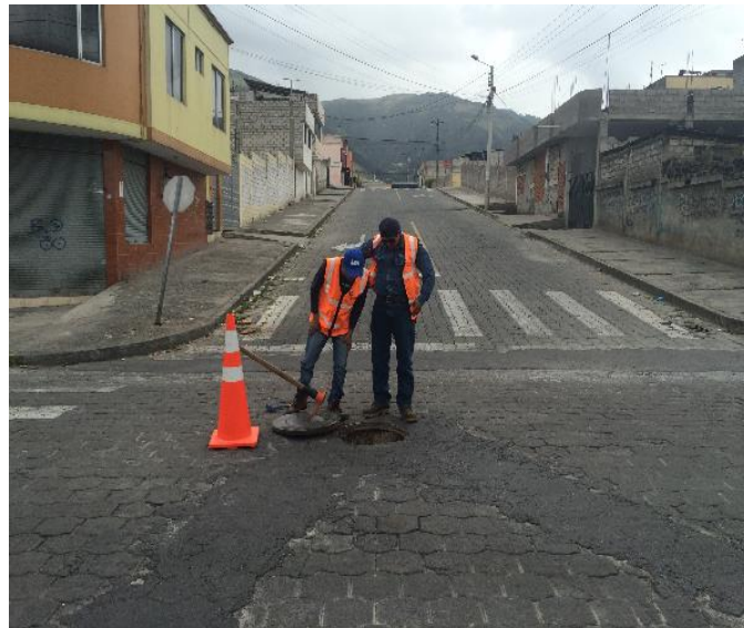
Fotografía 1. Inspección de pozos con personal de EPMAPS
