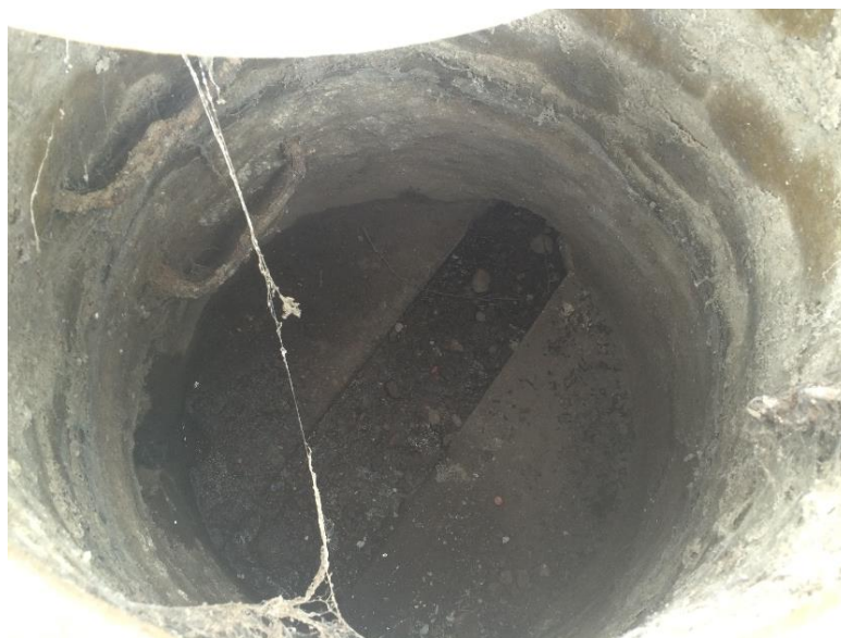
Fotografía 2. Revisión de pozos
