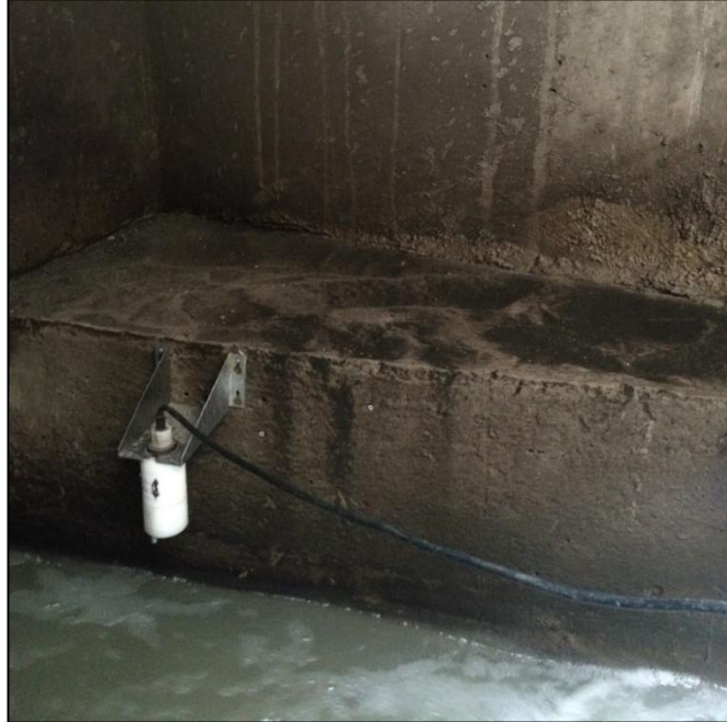
Fotografía 9. Instalación del sensor
