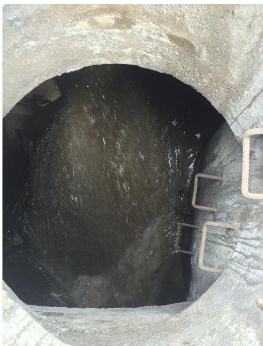
Fotografía 3. Revisión de pozos
