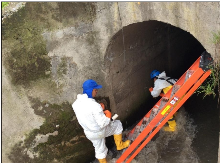
Fotografía 6. Perforación para fijar apoyo del sensor
