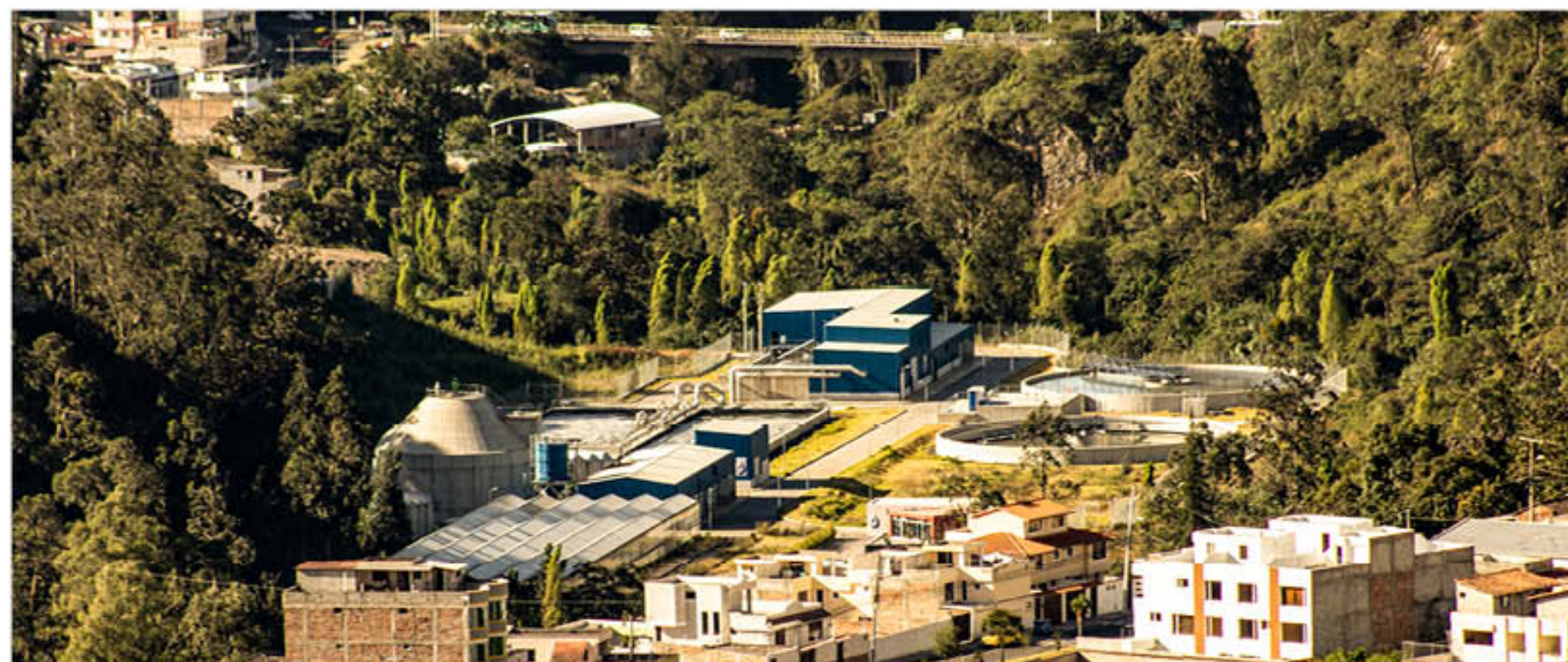
Ilustración 75: Planta de tratamiento ubicada en la ribera oeste del Río Tahuando. Fuente: Elaboración propia.
