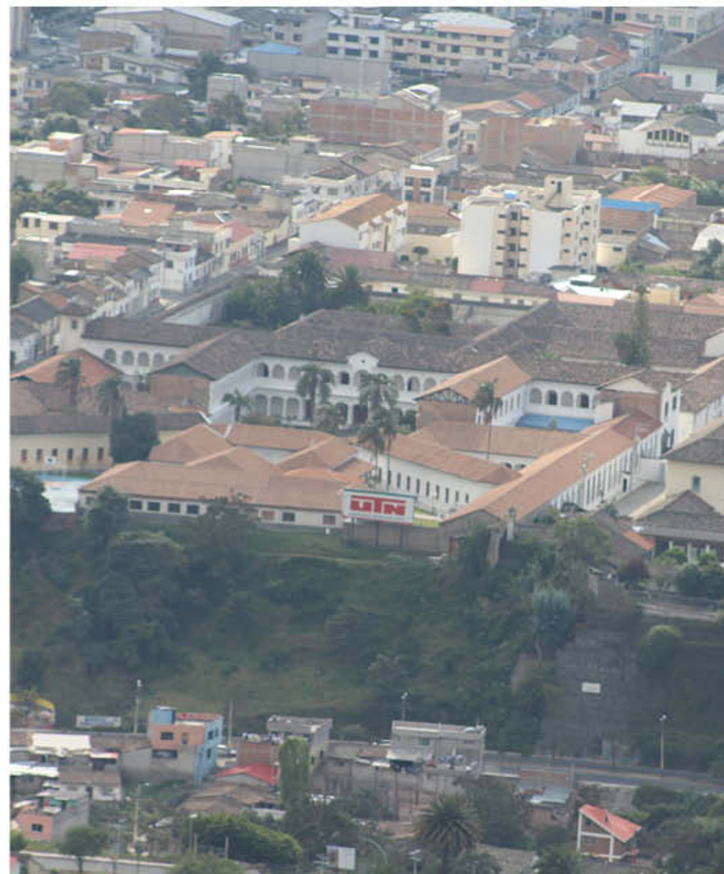
Ilustración 10: Vista de la ribera oeste, Hospital San Vicente de Paúl. Fuente: Elaboración propia-2018
