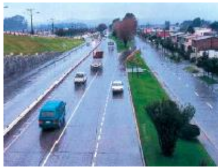
Ilustración 3-11 Comparación de una vía sin y con demarcación Fuente: Dourthé Castrillón & Salamanca Candia, 2003
