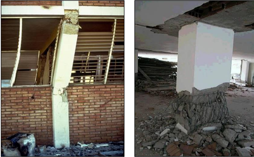
Figura 2.- Diferentes tipos de falla de columnas luego de un evento de naturaleza sísmica.
