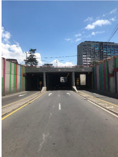
Figure 22 Paso inferior Avenida Patria y 12 de octubre – Entrada Sur
