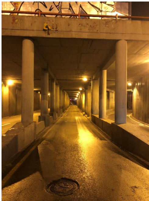
Figure 29 Iluminación interior Paso inferior Av. Patria y 12 de octubre
