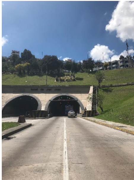
Figure 24 Túnel de San Juan
