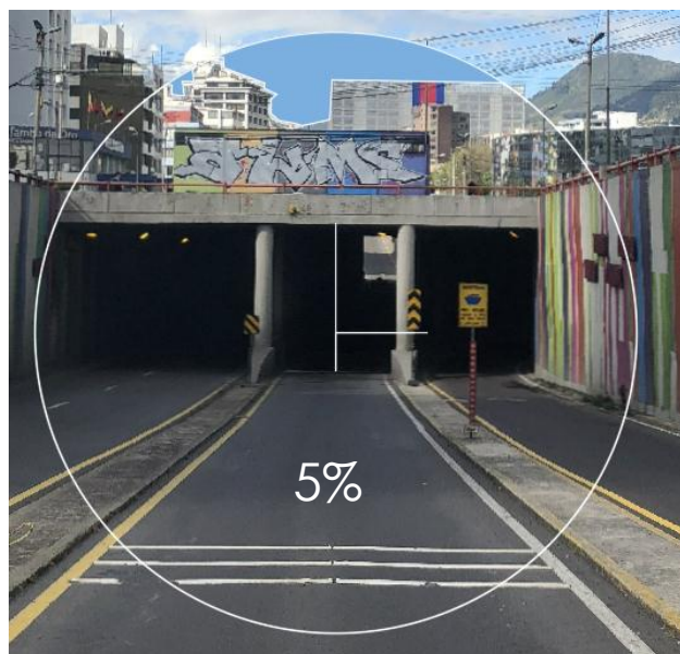
Figure 17 Porcentaje de cielo – Paso inferior Av. Patria y 12 de octubre – Entrada Norte
