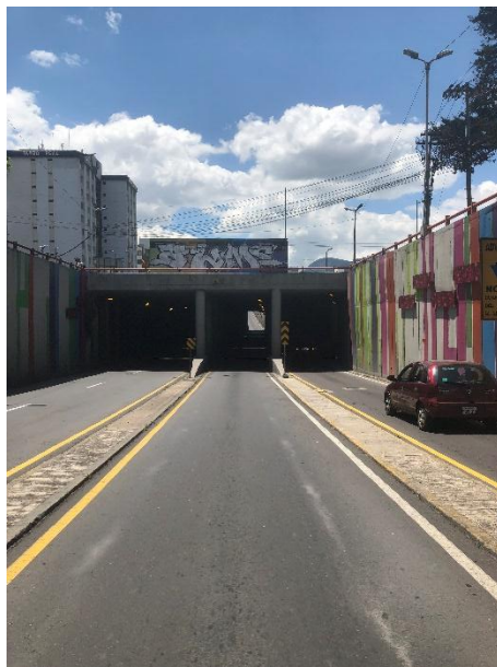
Figure 23 Paso inferior Avenida Patria y 12 de octubre – Entrada Norte
