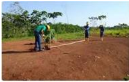
COLOCACIÓN DE BALIZAS
