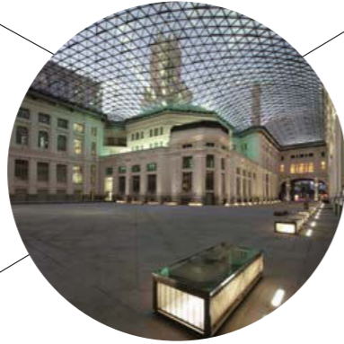
Cubierta en Patios
