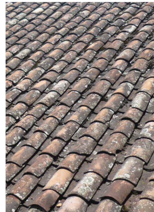
Gráfico 298: Teja Tradicional - Estructura de madera Fuente: Elaboración propia
