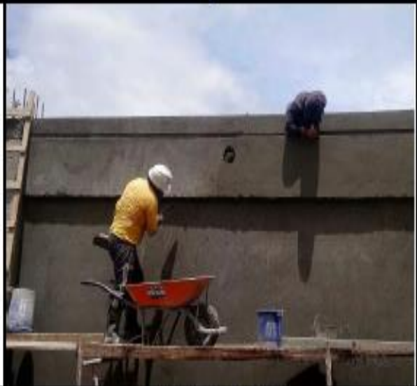
Enlucido vertical en vigas
