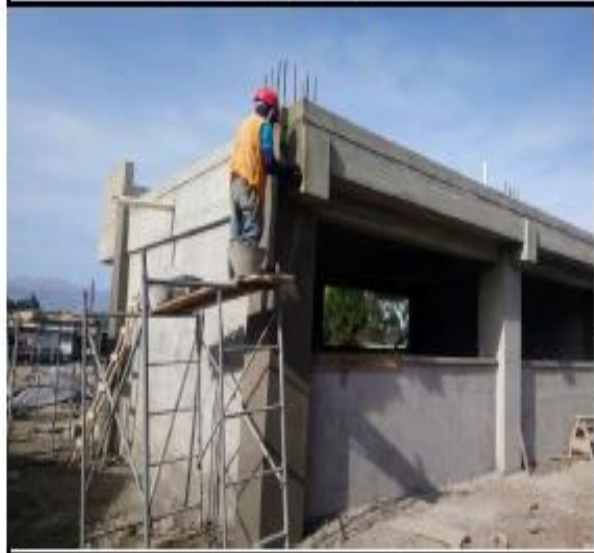
Enlucido vertical en columnas y vigas
