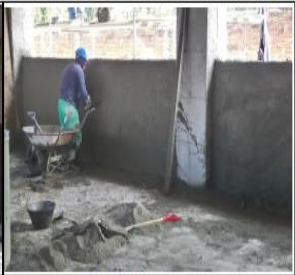
Enlucido vertical paredes interiores
