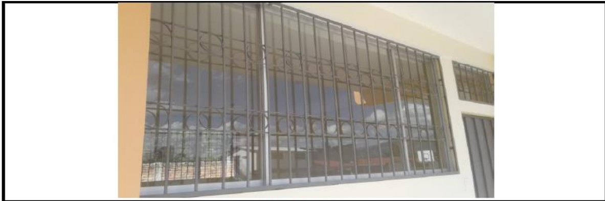
Rejas metálicas instaladas
