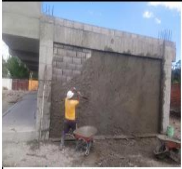
Enlucido vertical paredes exteriores
