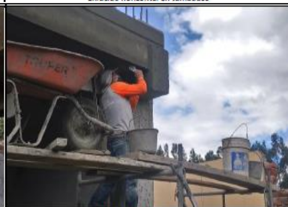
Enlucido horizontal en vigas
