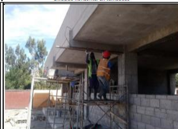
Enlucido horizontal en vigas
