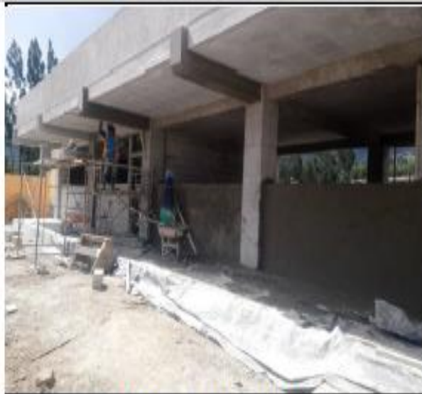
Enlucido vertical paredes exteriores
