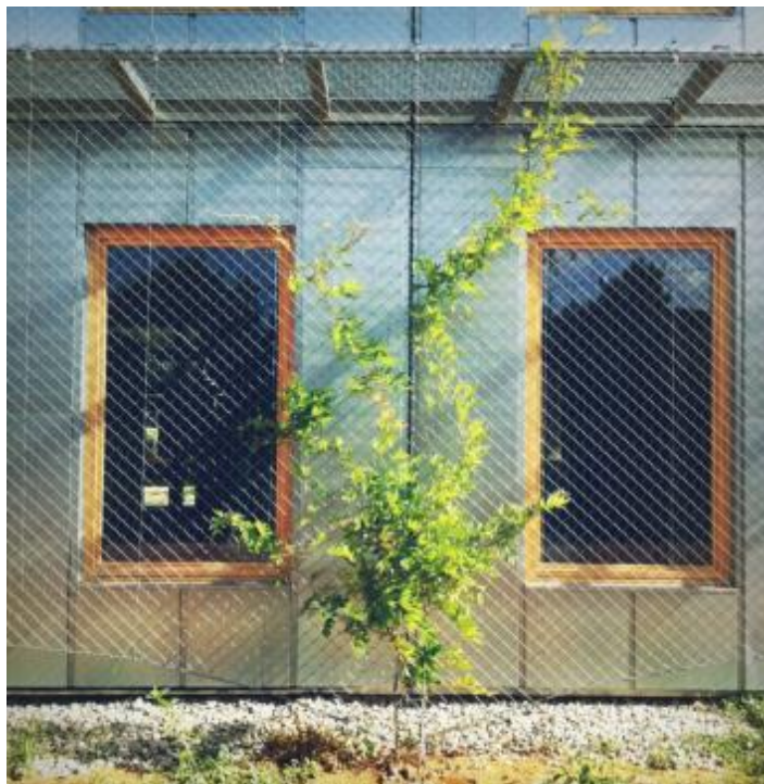
imagen 16: Detalle de malla en la fachada.(H Arquitectes + dataAE, 2015)
