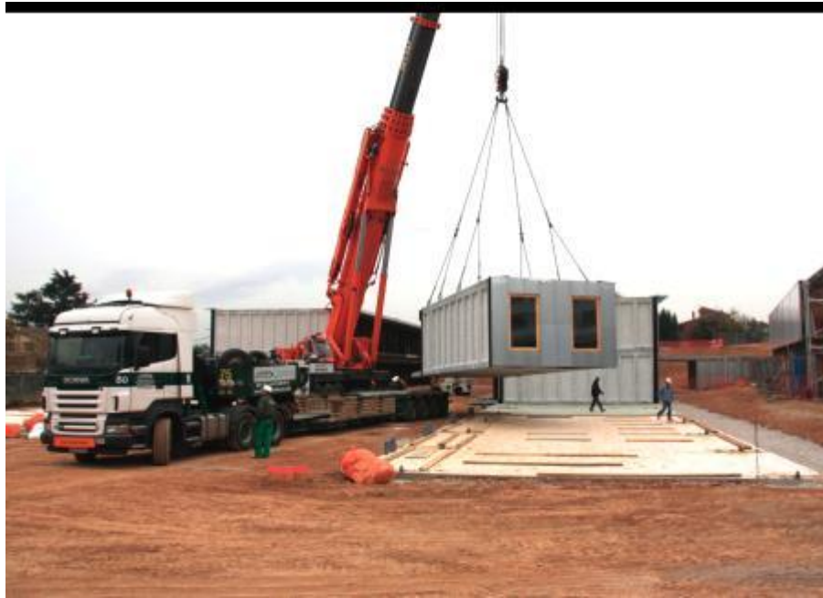
imagen 15: Contenedores como módulos. (H Arquitectes + dataAE, 2015)
