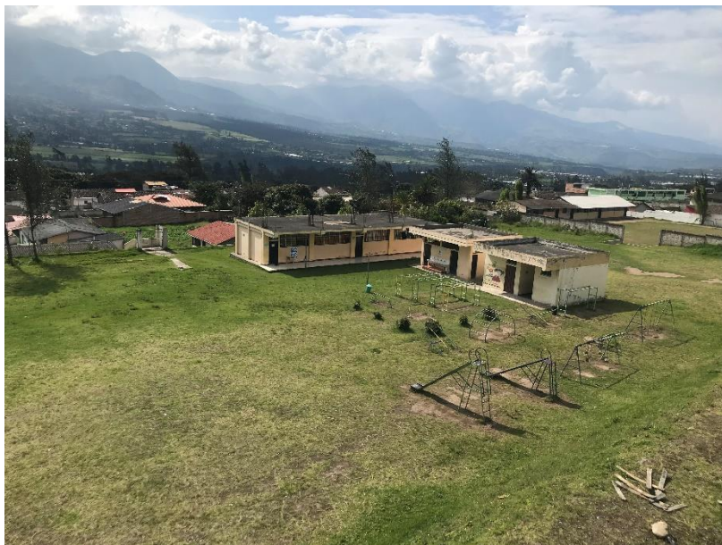
Figura 42. Patio y aulas del bloque 2. Fuente: autoría propia.
