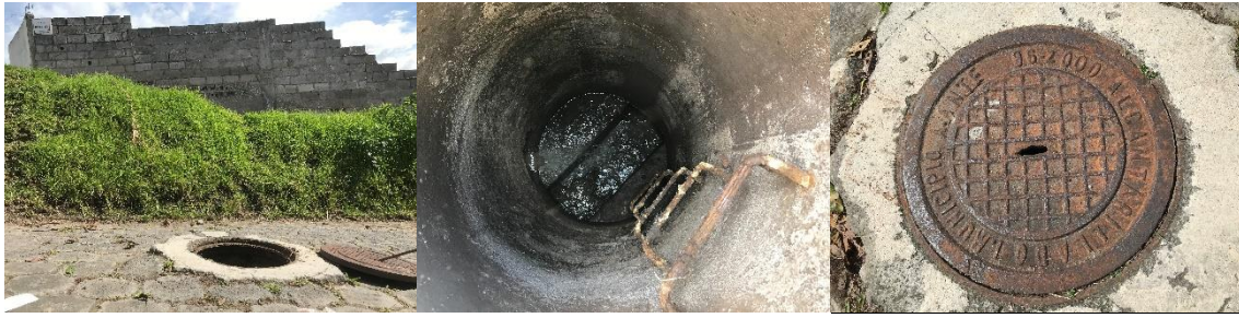
Figura 23. Fotografías caja de revisión calle Luis Buitrón. Fuente: autoría propia
