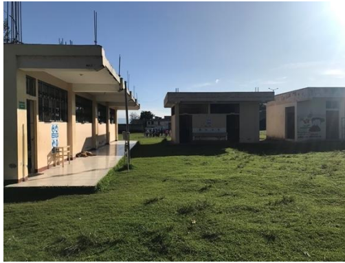
Figura 38. Espacios verdes podados y limpios en el bloque 2. Fuente: autoría propia
