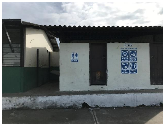
Figura 37. Baños bloque 4. Fuente: autoría propia
