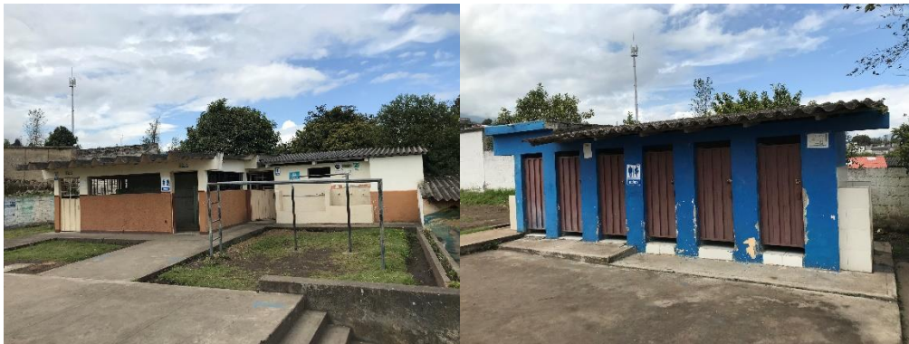
Figura 36. Baños bloque 3. Fuente autoría propia.
