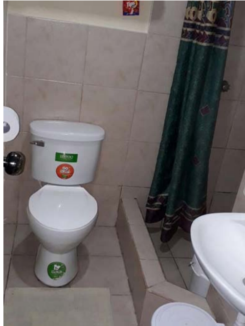
Imagen 32. Baño vivienda tipo Tohalli-02 de noviembre de 2018
