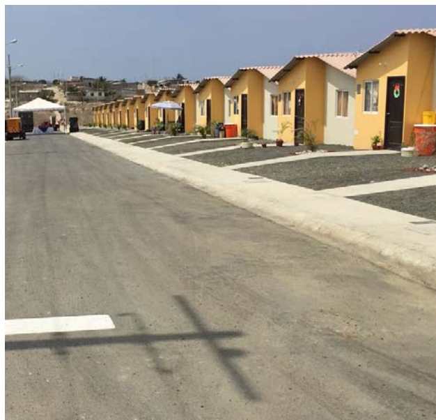
Imagen 27. Vivienda tohalli 21 de septiembre del 2016
