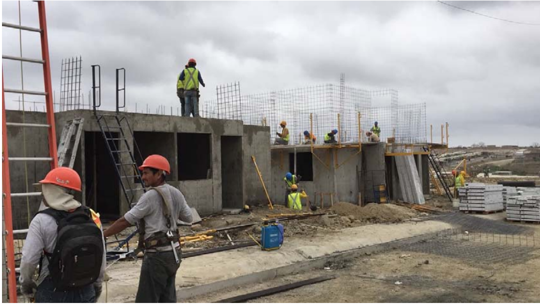
Imagen 14. Proceso constructivo Bloque de departamentos
