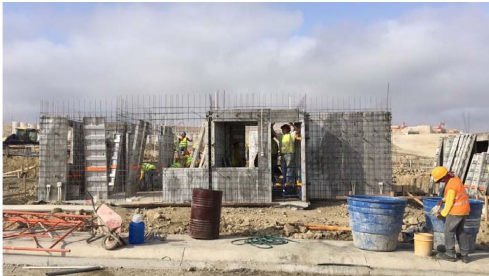
Imagen 13. Proceso constructivo Bloque de departamentos
