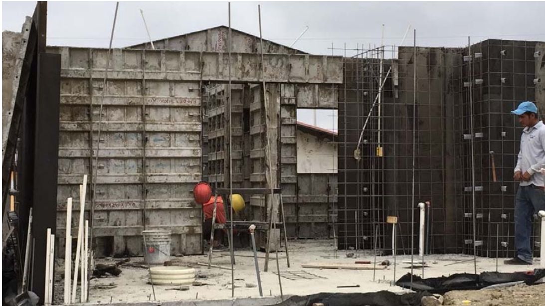
Imagen 15. Proceso constructivo vivienda unifamiliar
