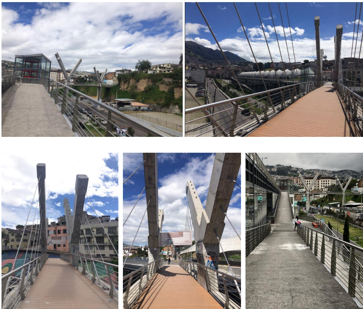
Imagen 13 – Puente elevado de conexión barrios La Loma y San Sebastián
