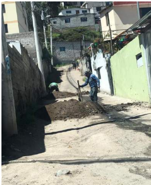
Ilustración 46. Vía en proceso de mejora
