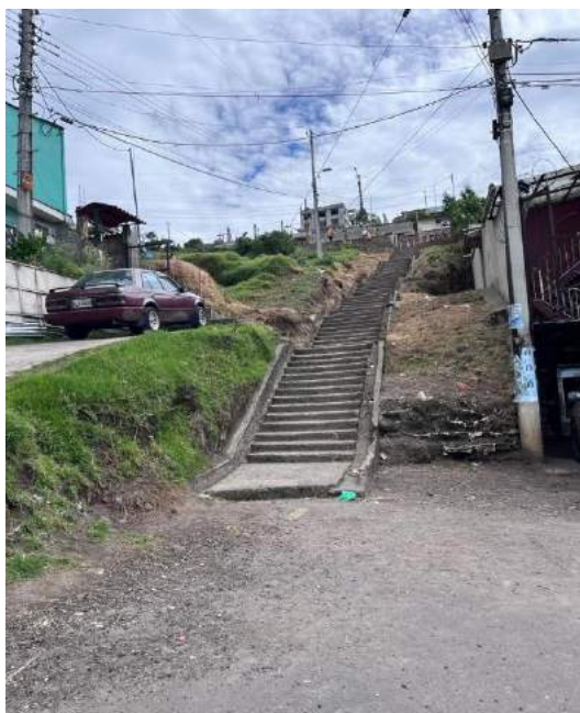
Ilustración 52. Escaleras en lugar de vía
