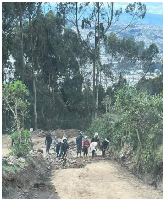
Ilustración 51. Vía en proceso de mejora
