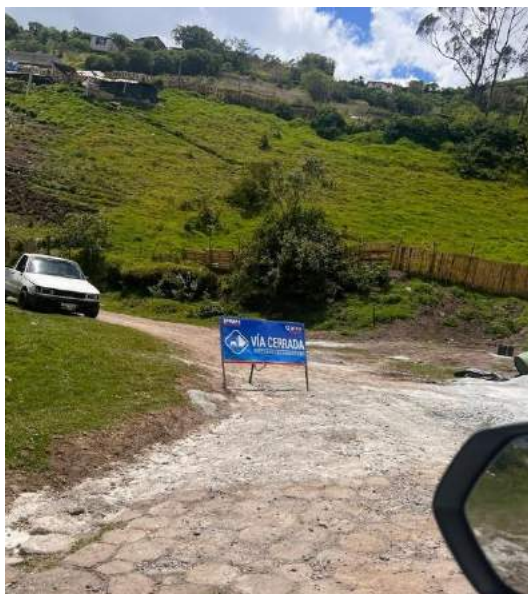
Ilustración 47. Vía en proceso de mejora
