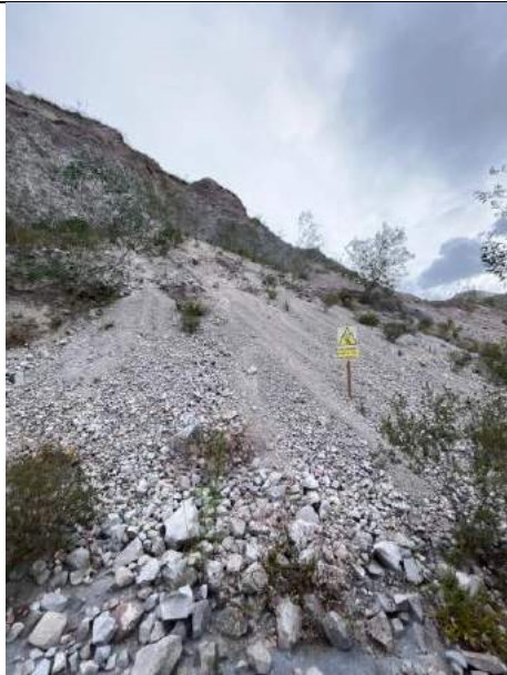
Ilustración 45. Talud de Material Suelto
