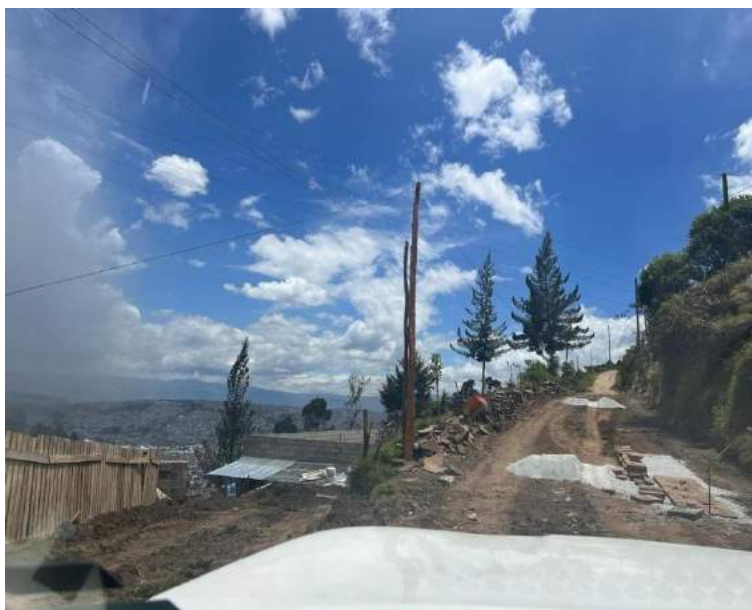
Ilustración 49. Vía en proceso de mejora
