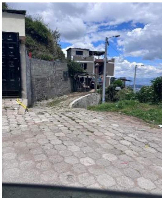
Ilustración 63. Vía con tramo cortado
