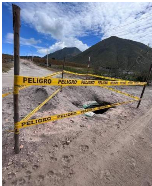
Ilustración 50. Vía en proceso de mejora
