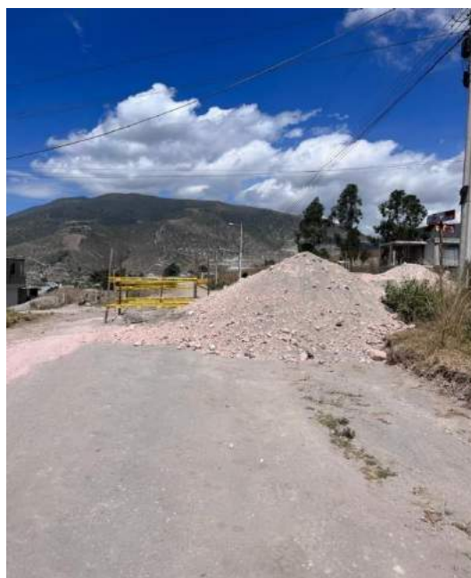
Ilustración 48. Vía en proceso de mejora
