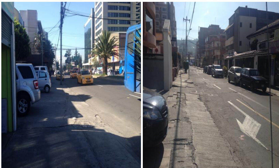
Figura 4.31. Estado de la superficie de vereda
