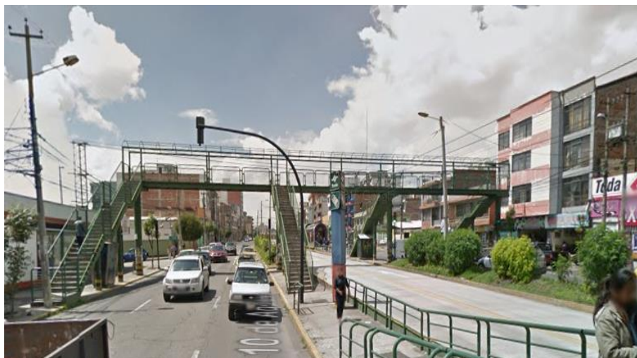
Figura 3.13. Paso peatonal – Av. 10 de Agosto
