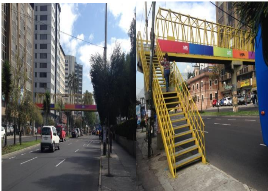
Figura 3.20. Paso Peatonal Av. 12 de Octubre
