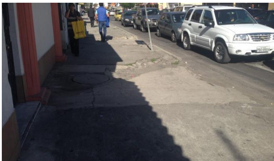
Figura 3.5. Acera - Calle el telégrafo
