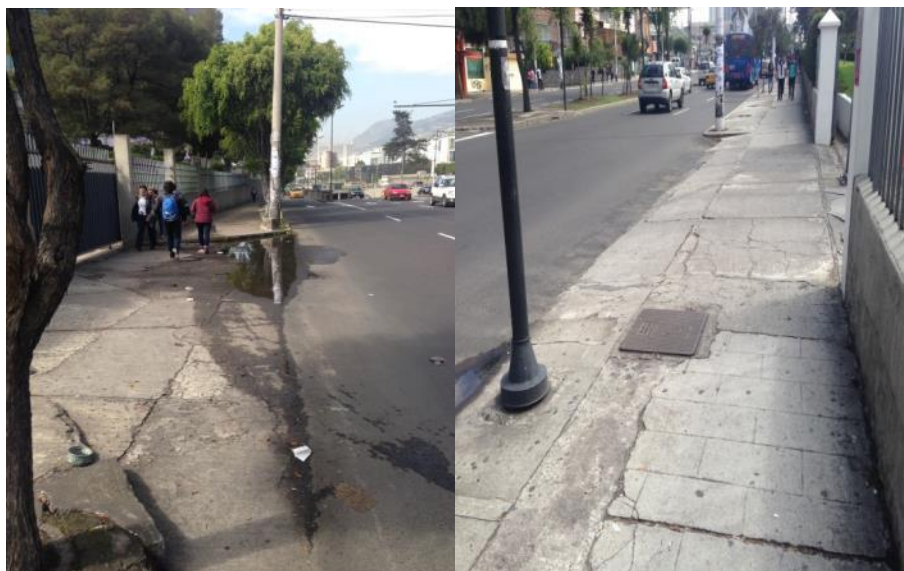
Figura 3.15. Aceras – Av. 12 de Octubre
