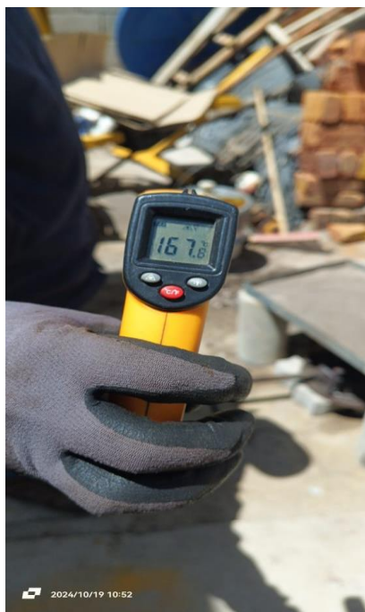
Ilustración 16. Chequeo de temperatura de agregados y asfalto líquido
