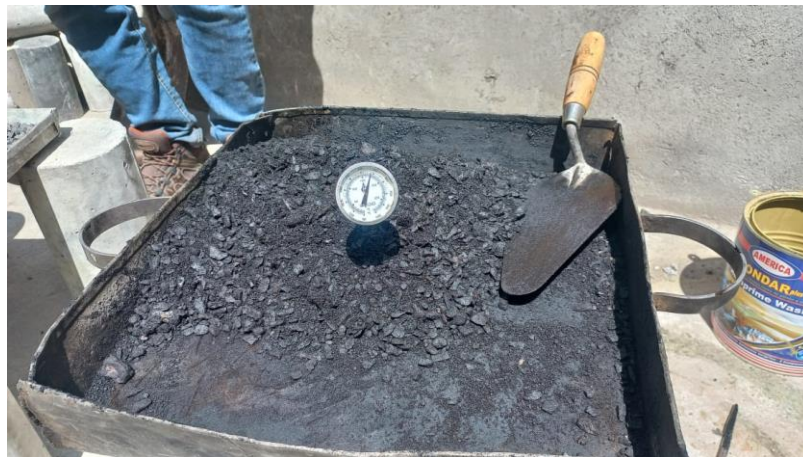
Ilustración 11. Colocación de emulsión asfáltica y toma de temperatura
