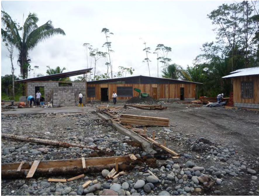
Ilustración 3-13: Construcción de campamento
