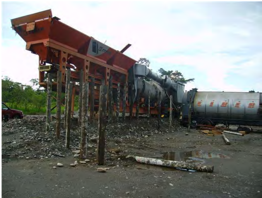
Ilustración 3-19: Instalación de planta asfáltica
