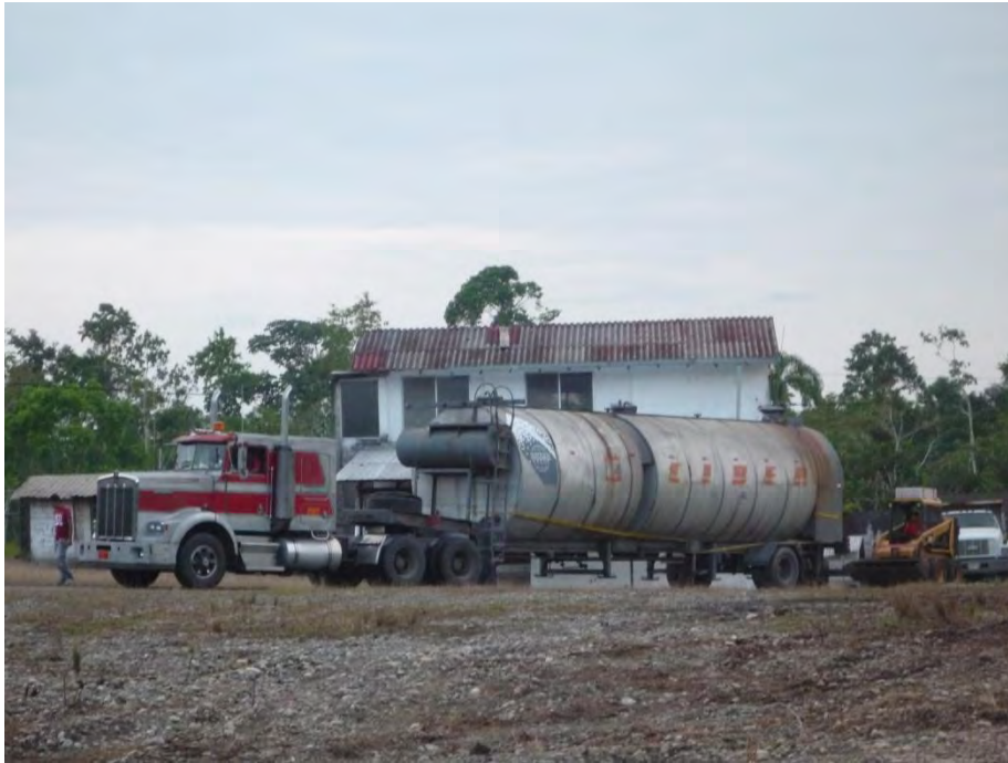
Ilustración 3-18: Traslado de planta asfáltica
