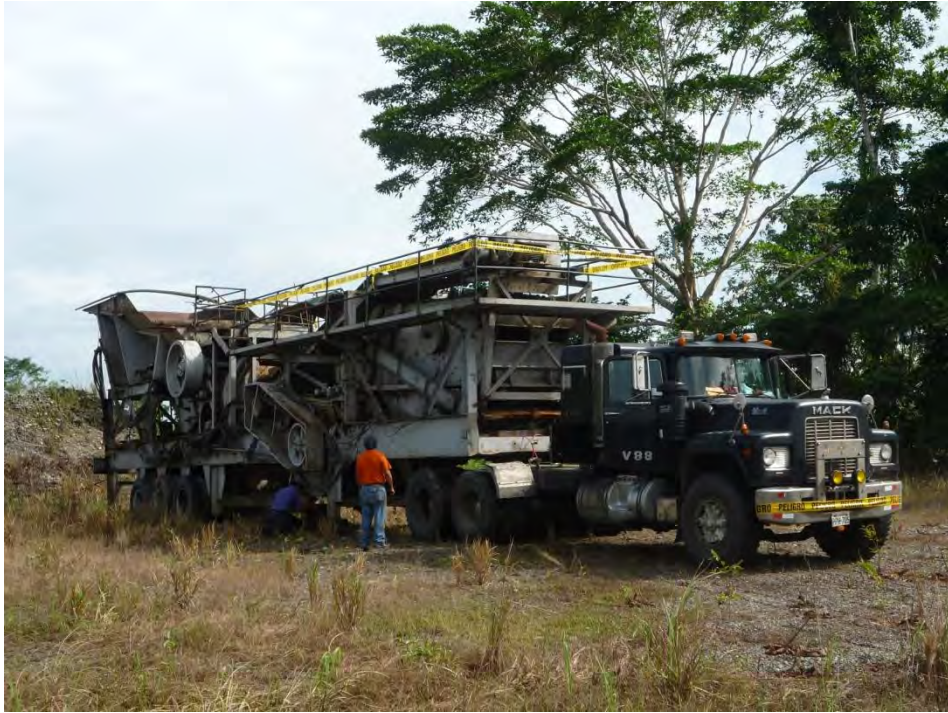
Ilustración 3-16: Instalación de planta de trituración
