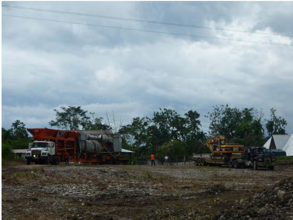
Ilustración 4-1: Traslado y ubicación de la maquinaria en la obra
