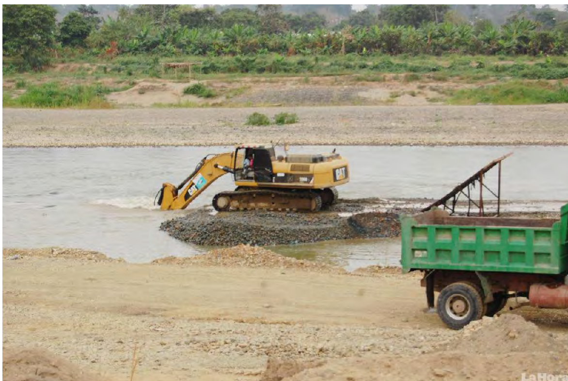
Ilustración 3-3: Extracción de material en el río Quevedo
