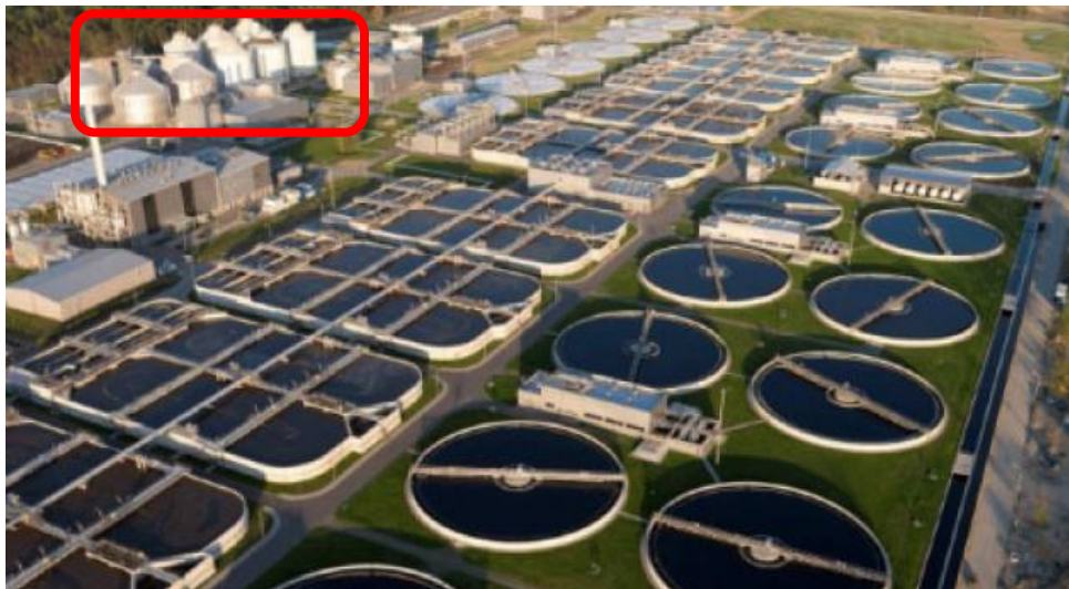
Imagen 18 Planta de Tratamiento de Aguas Residuales en Varsovia
