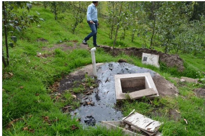
Tomada en la visita 3. Fuente: Indira Jackeline Chiriboga Sisalema
