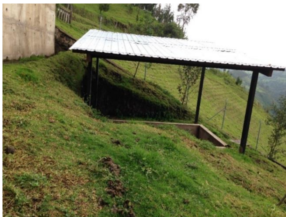
Foto 45 Lecho de secado de lodos
