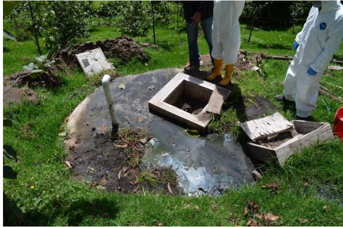
Foto 34 Cuarto pozo de infiltración
