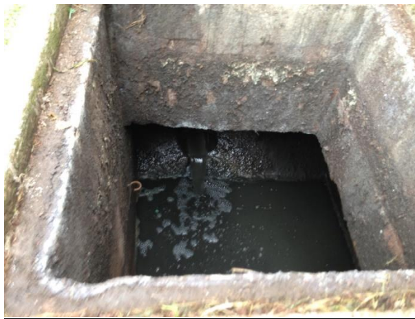
Tomada en la visita 1. Fuente: Indira Jackeline Chiriboga Sisalema
