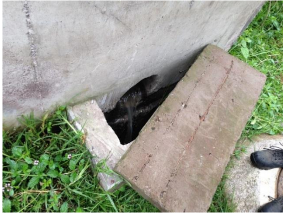
Tomada en la visita 1. Fuente: Indira Jackeline Chiriboga Sisalema
