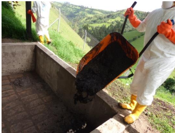
Foto 44 Colocación de los lodos en el lecho de secado
