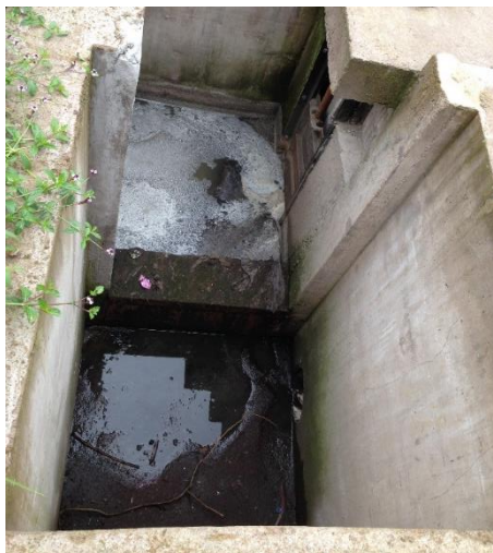
Foto 9 Cámara 1 y Cámara 2
