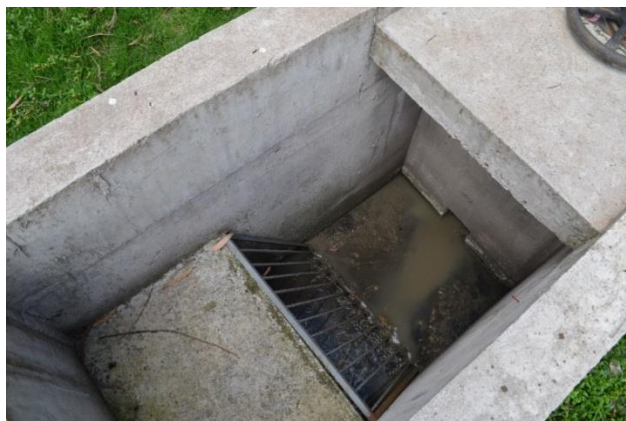
Tomada en la visita 2. Fuente: Indira Jackeline Chiriboga Sisalema
