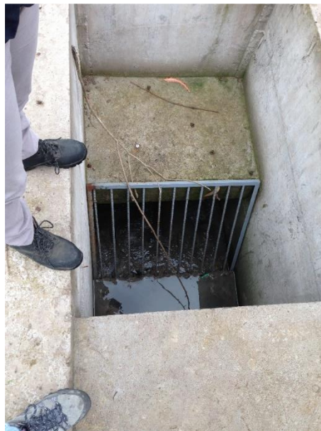
Tomada en la visita 1. Fuente: Indira Jackeline Chiriboga Sisalema
