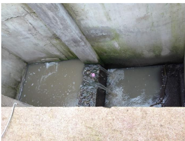
Foto 10 Cámara 1 y Cámara 2
